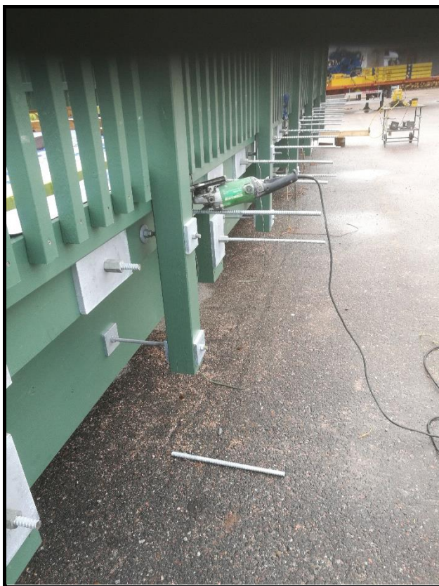
Kuva 15. Viimeinen kiristys ja terästen katkaisu.
