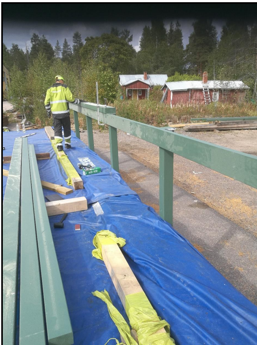
Kuva 13. Johteiden asennus.
