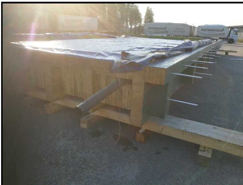
Kuva 10. Vetoteräkset paikallaan.
