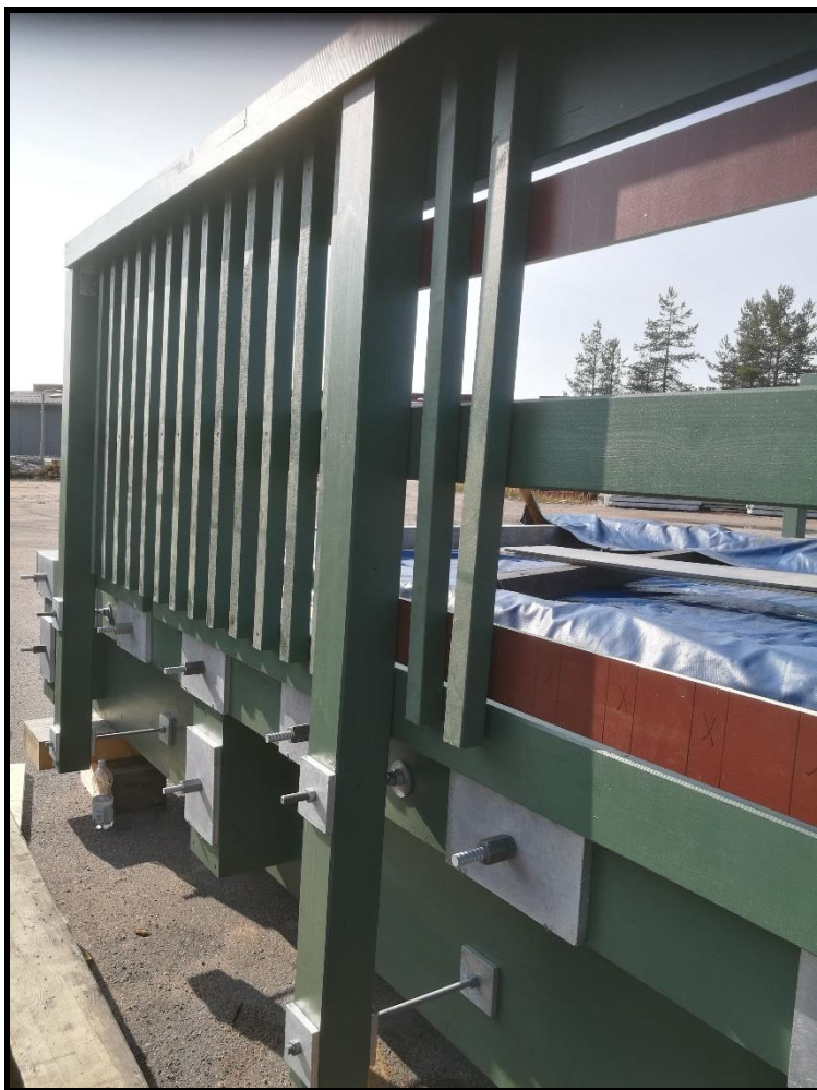
Kuva 14. Pystypinnojen asennus.
