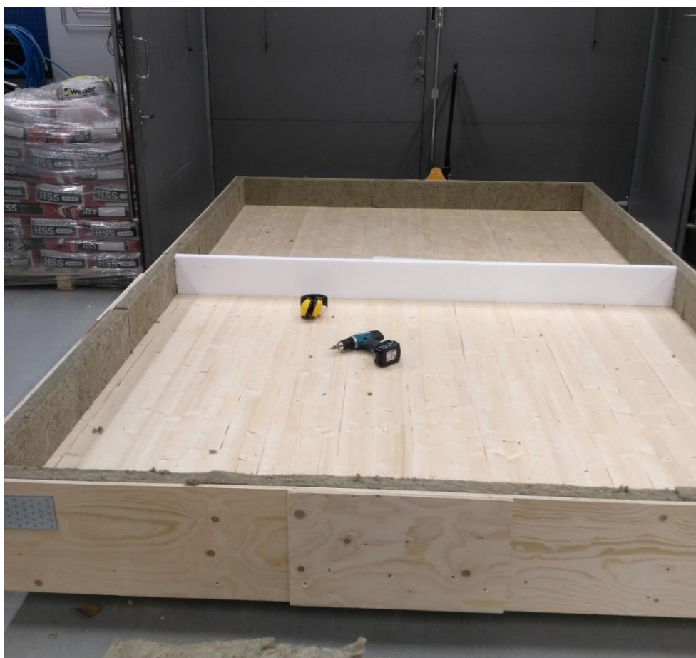
Kuva 14. Välipohjan rakentaminen alkoi rungon kokoamisella.
