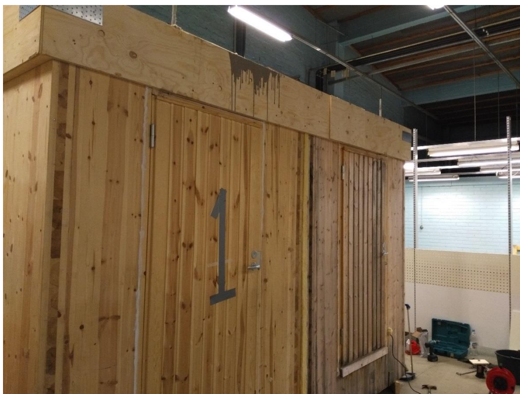
Kuva 16. Kuvassa valmis välipohjarakenne on siirretty tilaelementtien päälle.
