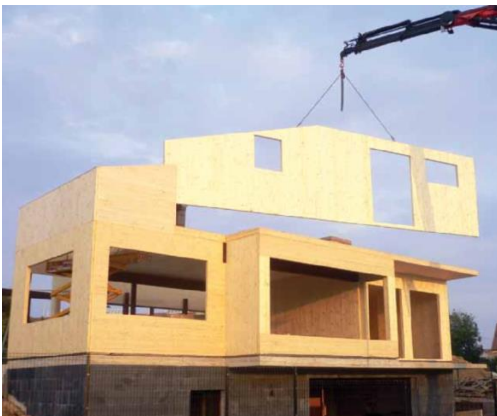
Kuva 2. CLT-elementin asennus (CLT-talo).
