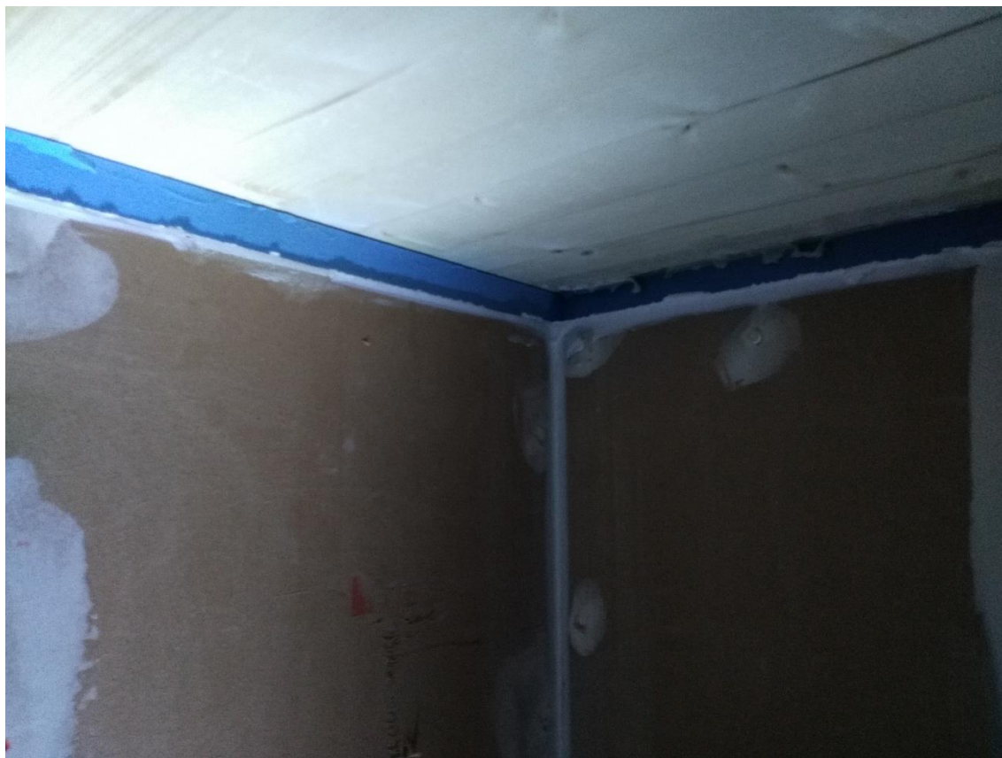
Kuva 17. Yhtenä tiivisteenä välipohjan ja tilaelementtien välissä käytettiin 25 mm:n paksuista Sylomer-täriäeristettä.
