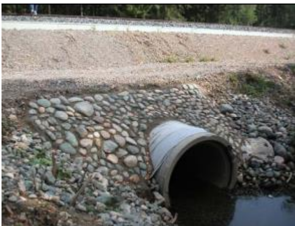
Kuvio 5 Viimeistelty betoniputkirumpu (RUMKO 2006, osa 2, 9)
