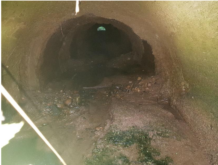
Kuvio 13 Liettynyt rumpu, jossa putket siirtyneet ja täyttömateriaali valunut rummun sisään
