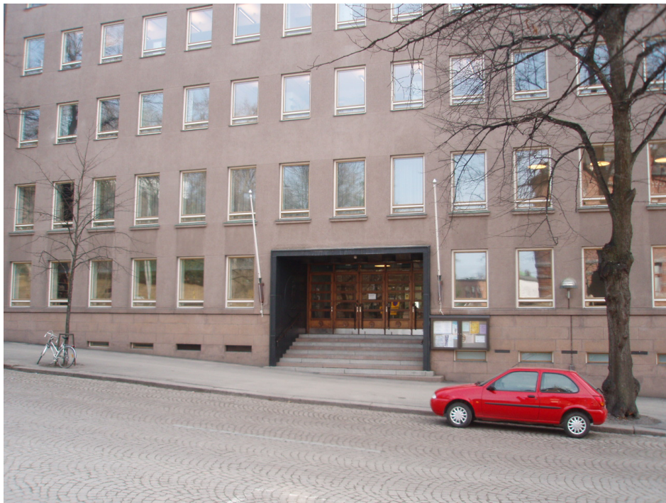
KUVIO 5. AV-lainaamo Kirkkokatu 5:ssä, ulkopuolelta
