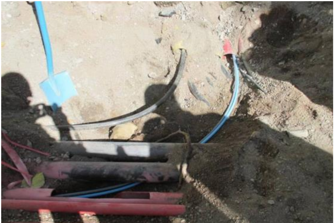
Kuva 7. Vanhoihin putkiin asennettu mikrokanava. (Kuva Jori Renfors)
