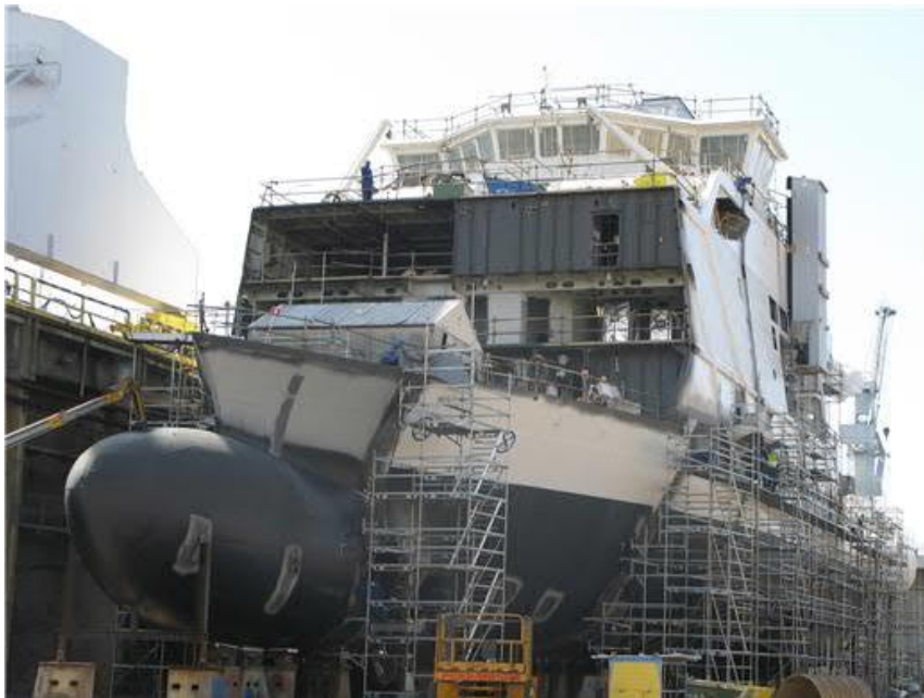
Kuva 7. Laiva keulasta päin katsottuna rakennusaltaassa (Rajavartiolaitos 2018b).
