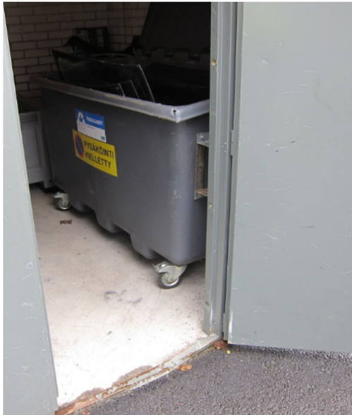
Kuva 17. Esimerkkikohteessa tila on pimeä, oviaukko on kapea eikä ovi pysy auki. (L&T 2017)
