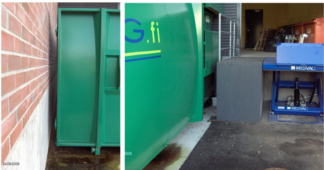
Kuva 19. Puristinkontin sivuille on jätettävä riittävästi tilaa siirtotyön valmistelua varten. Lisäksi näin tarkka sijoitus puristimelle edellyttää ohjauskiskoja maahan, jotta laitteen saa sijoitettua suoraan. (L&T 2017)
