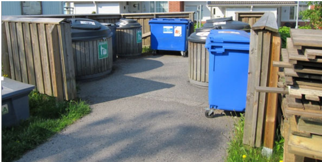
Kuva 20. Esimerkki kohteesta, jonka lähelle on vaikea päästä tarvittavalla tyhjennyskalustolla. (L&T 2017)
