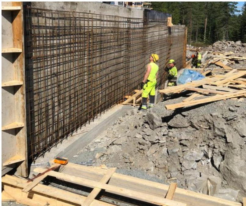
Kuva 3. Suurmuottien raudoitusta (Hirvelä)
