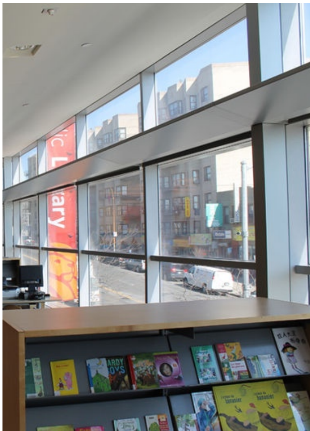
Kuva 17. Sisäpuolinen valohylly heijastaa siihen osuvaa valoa alakattoon. (Kuva: Julian A. Henderson, Wikimedia Commons)
