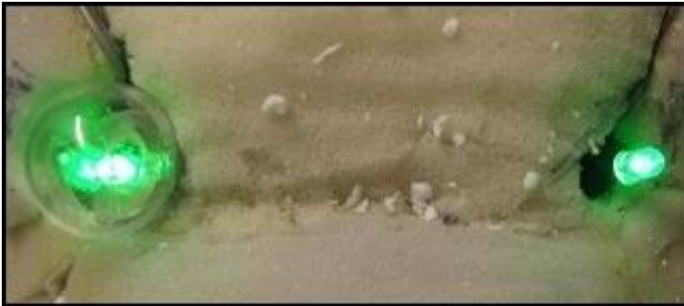
KUVA 27. Led-valon päällä oleva suoja.
