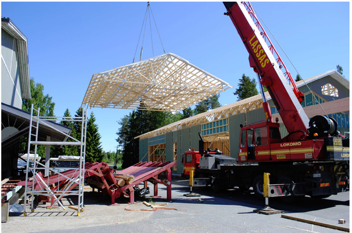
Kuva 1. Ristikolohkon asennus (Veistämö M.Kortnesniemi Ky, [viitattu 27.7.2018]).
