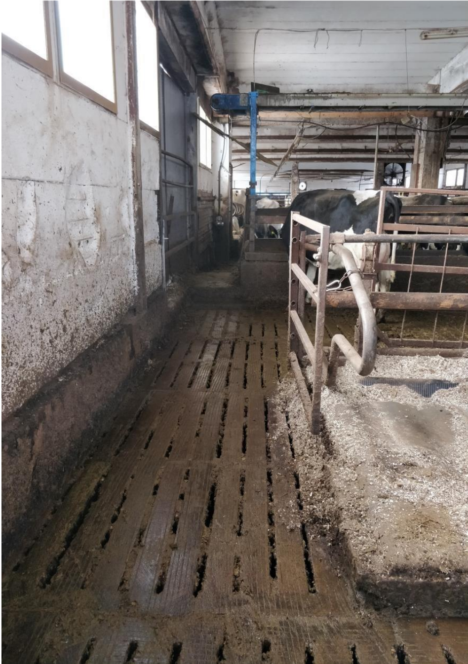
Kuva 7. Navetan vanhimman osan pääty. Kuvassa navetan vanhimman osan pääty, jossa vasemmalla näkyy ovi, josta kuivikkeet on tähän asti kannettu. Ruokintapöydän ja oven väli, josta lehmät ajetaan lypsylle, on noin metrin leveä.
