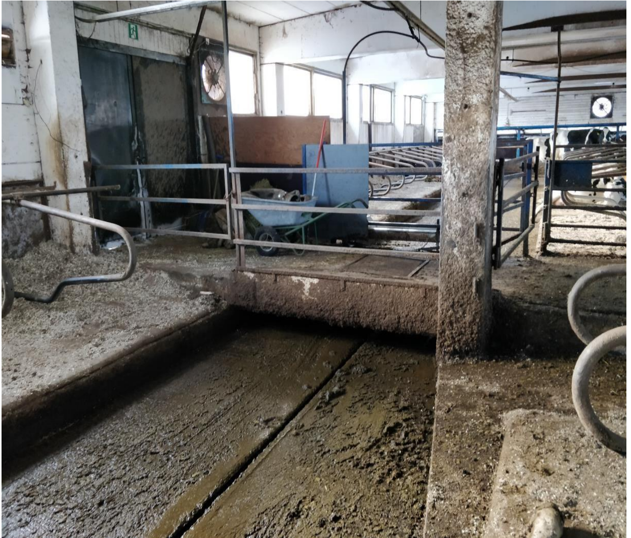
Kuva 9. Uusimman ja keskimmäisen laajennuksen välinen lantakuilu.
