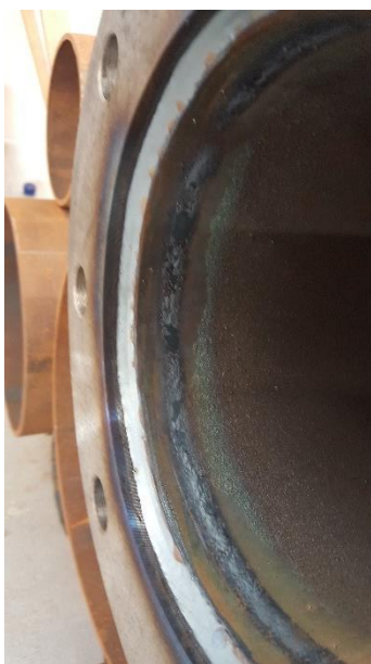
Kuva 12. Putken hitsatun levylaipan sisäsauma.
