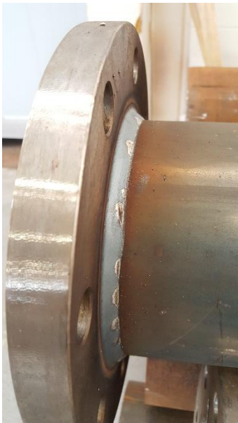
Kuva 11. Putkeen hitsatun levylaiipan ulkosauma.
