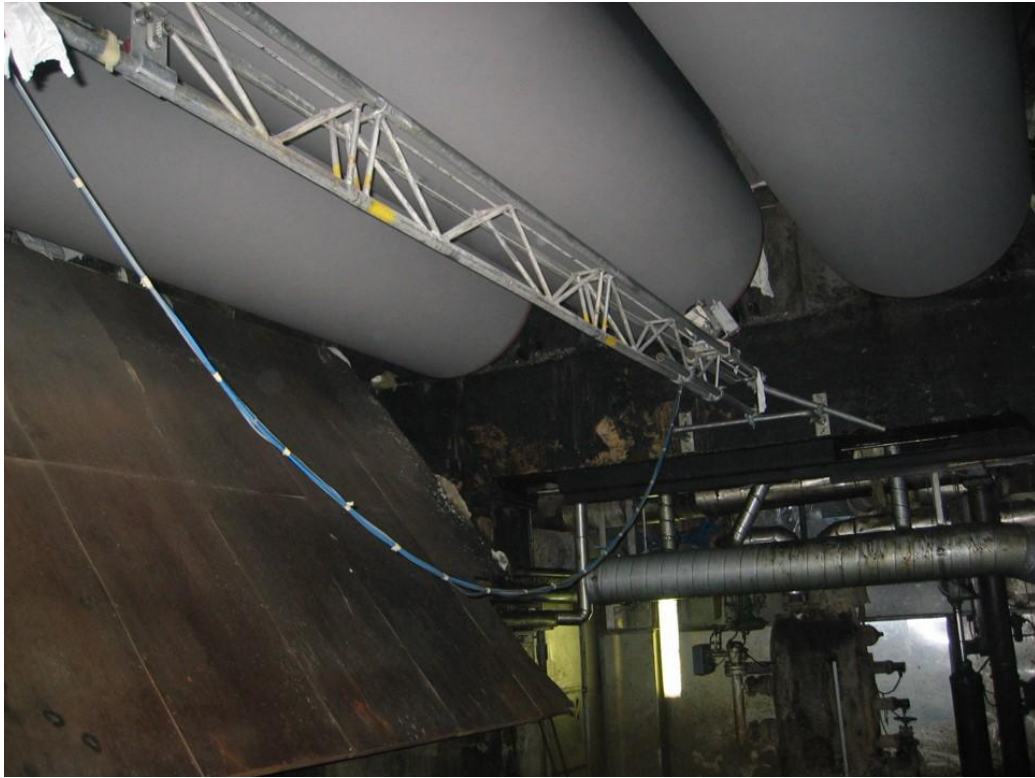
Kuvio 12. Rautpohjan kosteusprofiilimittausjärjestelmä asennettuna alkukuivatusosalle
