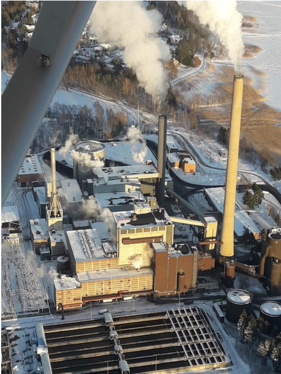
Kuvio 1. Ilmakuva Suomenojan voimalaitoksesta (Laipio 2018)
