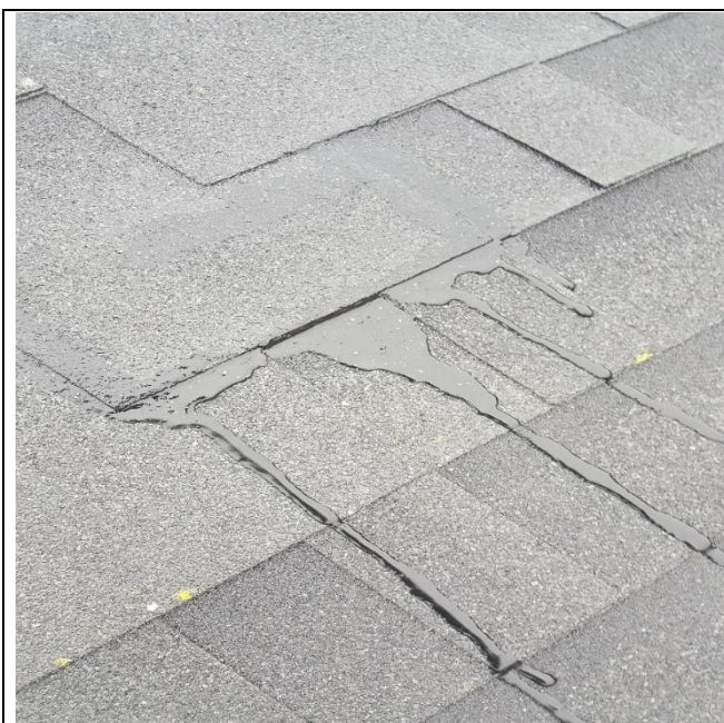
Kuva 12. Talo A:n palahuovassa tehty korjaus.
