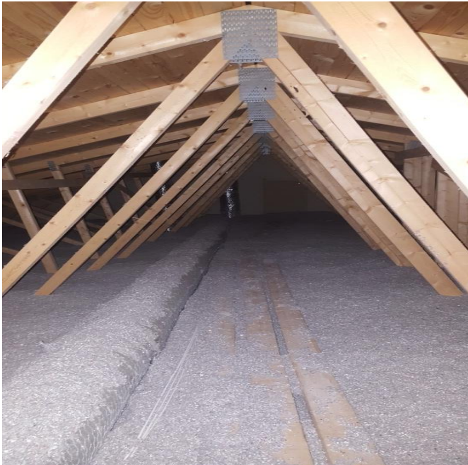
Kuva 6. Yläpohja lisälämmöneristys tehty 2015.
