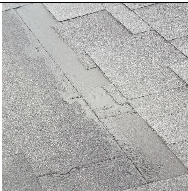
Kuva 13. Talo D:n palahuovassa tehty korjaus.
