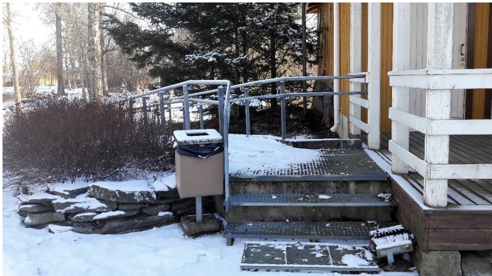
Kuva 12. Päädyn ramppi, metalliportaat ja liuskekivimuuri (Ojanen 2017).
