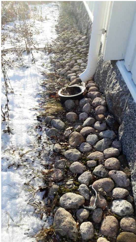
Kuva 16. Heitokekiveysmäinen seinänvieruskiveys (Ojanen 2017).
