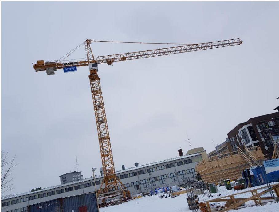
KUVA 4. Työmaan torninosturi Liebherr 200 EC-H-12 (Bärholm)
