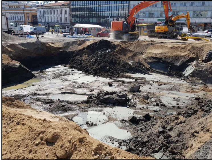
Kuva 3. Pilaantuneen maa-aineksen kaivanto melkein suurimmillaan.
