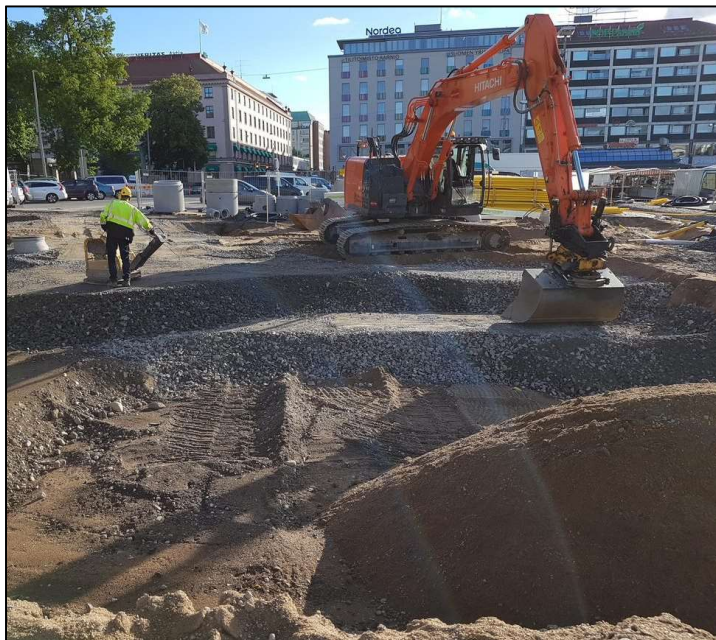
Kuva 5. Kaivannon täyttöä ja tiivistystä.
