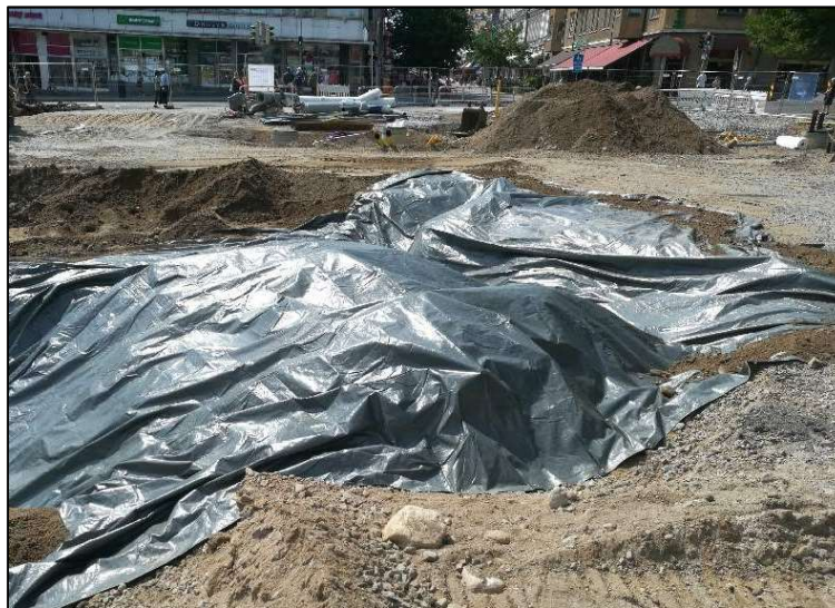
Kuva 4. Pilaantunut maa-aines suojattuna työpäivän päätteeksi.
