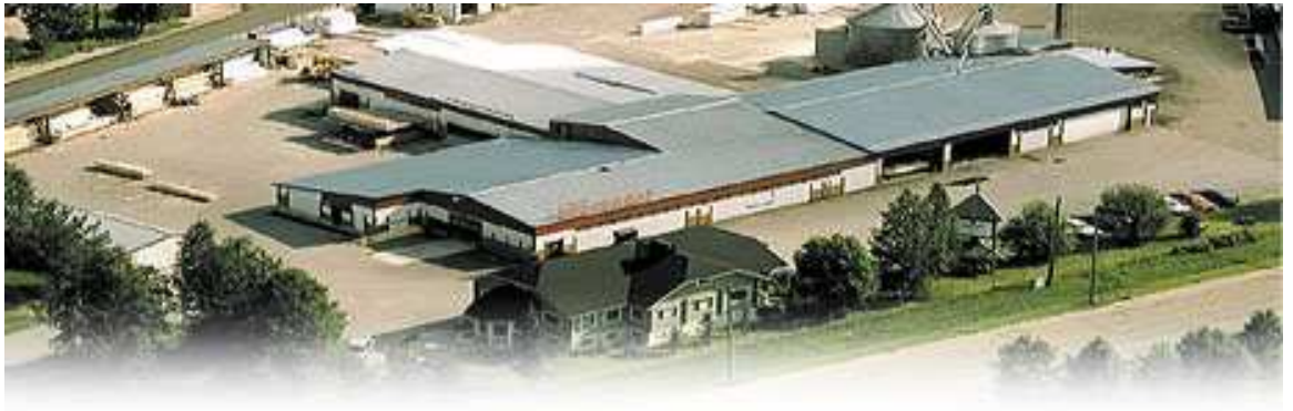
Kuva 5. Ilmakuva Vuokatti Hirsitalot Oy:n tehdasalueesta [14].
