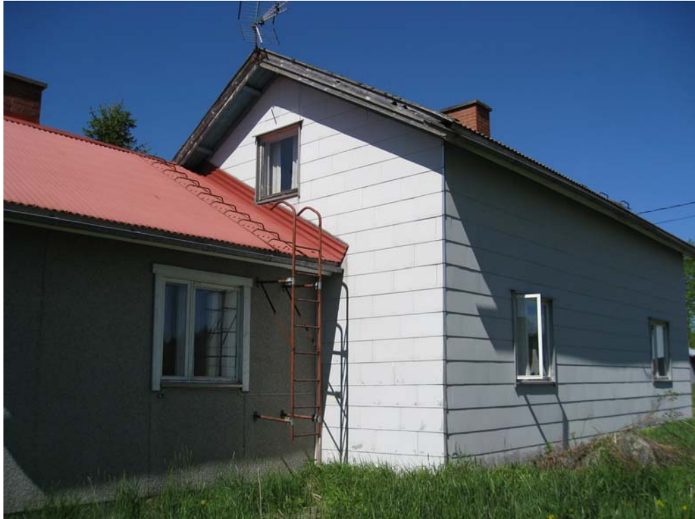
Kuva 3 Julkisivumateriaalit karaattilevy ja mineriittilevy (kuvannut Mikko Tapiola)
