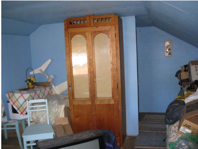
Kuva 4 Rakennuksen puolilämpimäksi suunniteltavat vinttitilat, joihin suunnitellaan YP3 ja US4 eris- tykset (kuvannut Mikko Tapiola).
