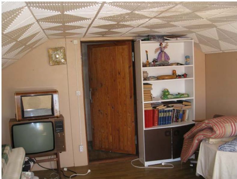
Kuva 5 Rakennuksen puolilämpimäksi suunniteltavat vinttitilat, joihin suunnitellaan YP3 ja US4 eris- tykset (kuvannut Mikko Tapiola).
