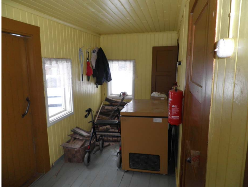
Kuva 6. Rakennuksen puolilämpimäksi suunniteltava eteinen, joihin suunnitellaan YP3 ja US4 eristykset (kuvannut Mikko Tapiola)
