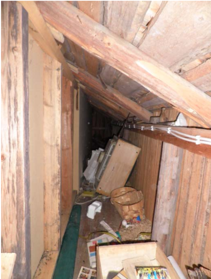
Kuva 3. Rakennuksen kylmäksi jäävä sivu vinttitila, johon suunnitellaan YP1 ja US4 eristykset (kuvannut Mikko Tapiola).
