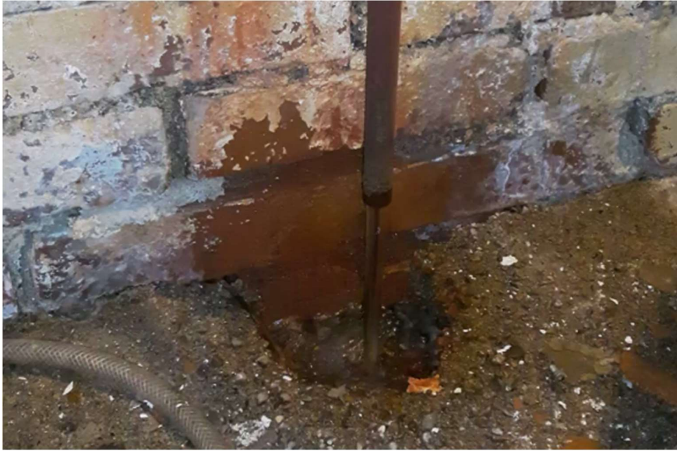
Kuvio 32. Seuraus vesilaitoksen vuotavasta vesitysventtiilistä
