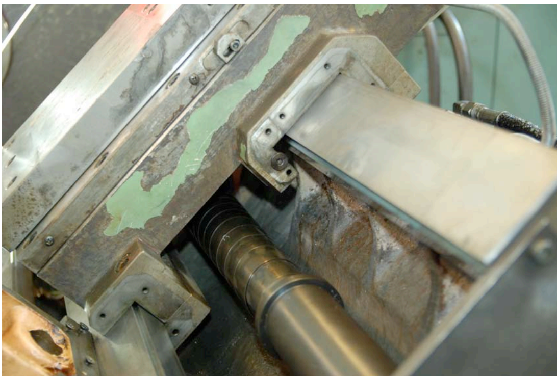
Kuva 4. Johteiden päällä oleva teräkelkka, kelkasta puuttuvat johteiden pyyhkijät sekä kelkan kiristyskiila, kuvassa keskellä jousimainen kuulamutteriruuvin suojus.
