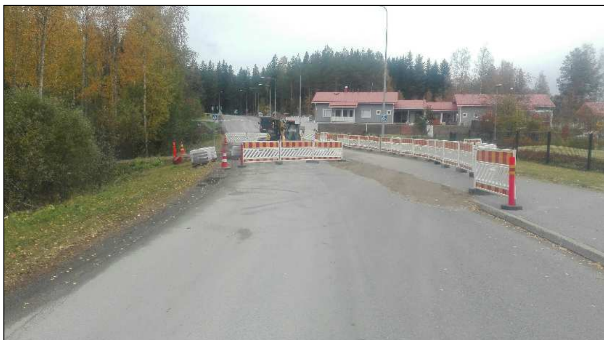
Kuva 2. Rautokannantien hidasteen rakentaminen (Kuopion Ympäristöpalvelut 2018.)
