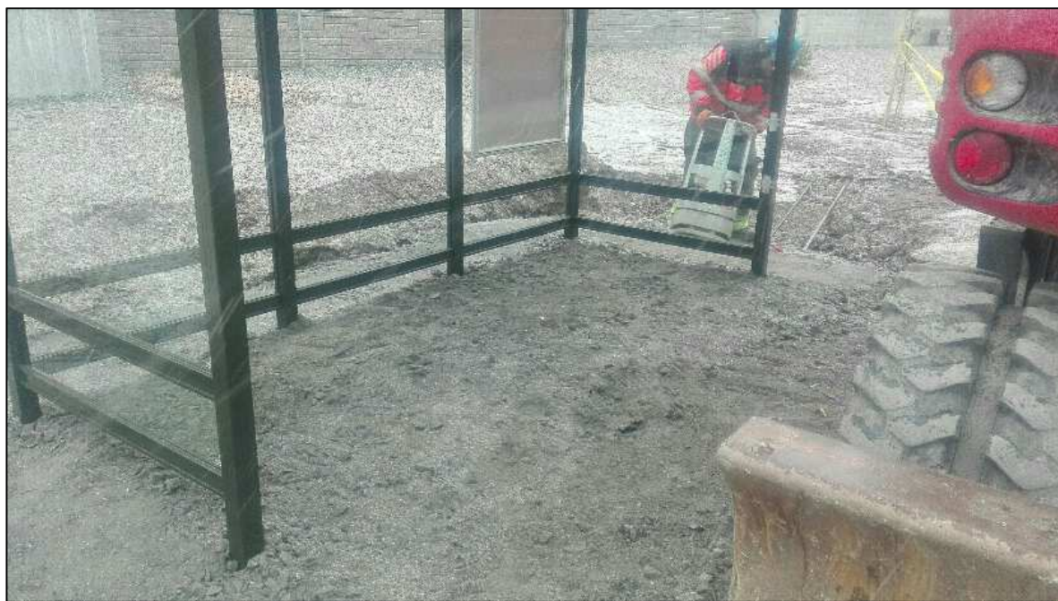
Kuva 5. Taivaanpankontien pysäkkikatoksen rakentaminen (Kuopion Ympäristöpalvelut 2018.)
