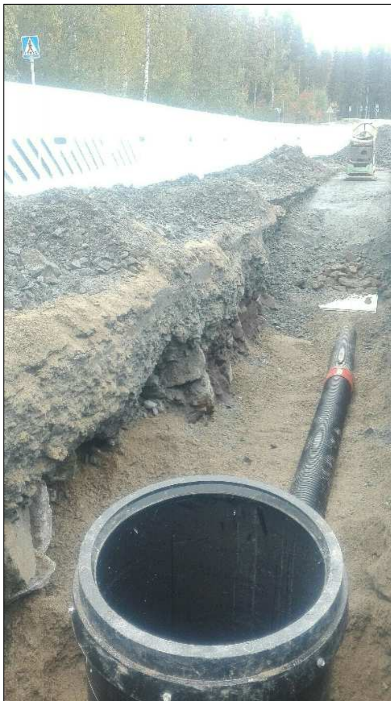
Kuva 4. Hulevesikaivon ja linjan rakentaminen ja eristys Rautokannantiellä (Kuopion Ympäristöpalvelut 2018.)
