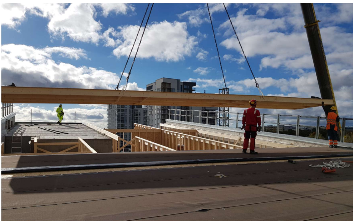
Kuva 12. Lähteen kattoelementtien nosto tukirakenteen päälle (Salopelto 2018).
