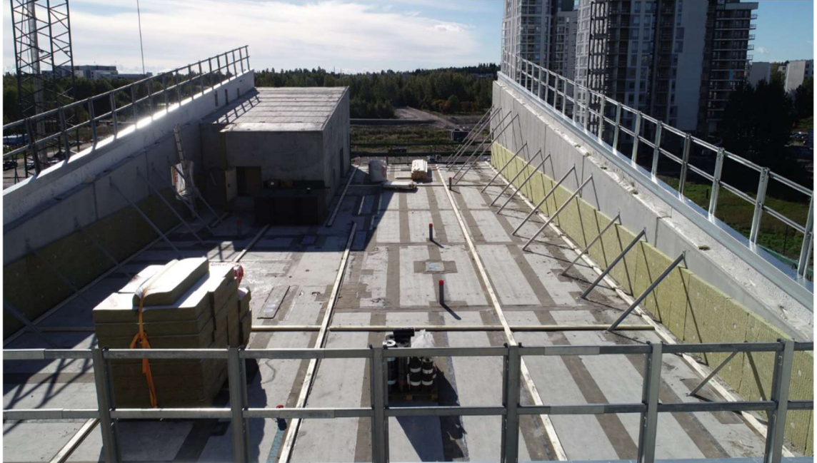
Kuva 8. Lähteen yläpohja valmiina vesikattotöiden aloitukselle (Helenius 2018).
