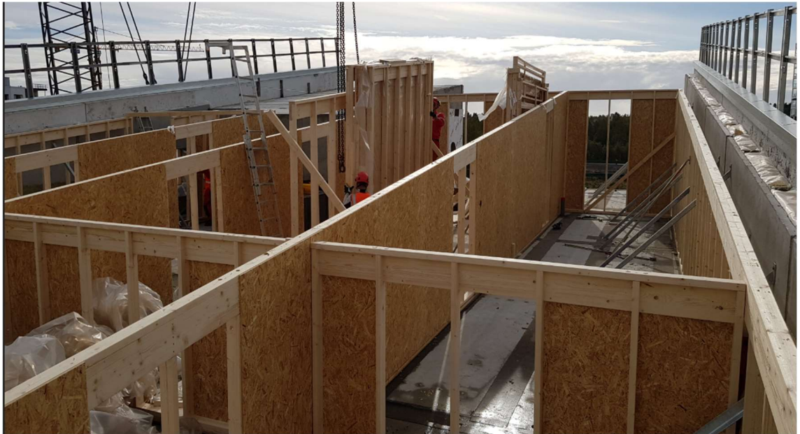
Kuva 10. Tukiseinät lähes valmiina Lähteen ensimmäisessä lohossa (Salopelto 2018).
