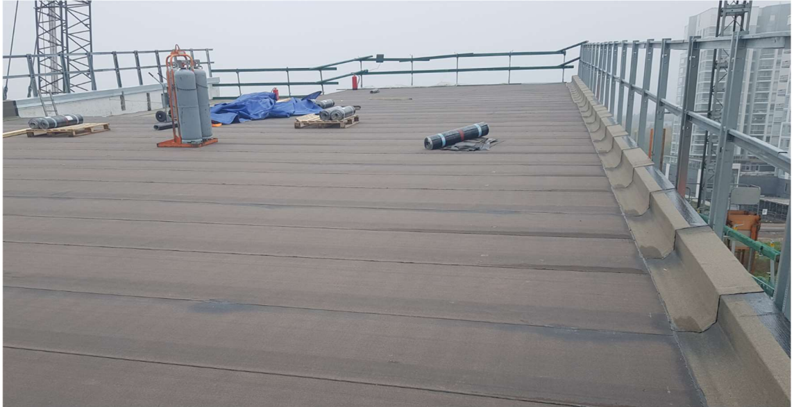
Kuva 13. Lähteen vesikatto sekä räystäät valmiilla aluskermipinnalla (Salopelto 2018).
