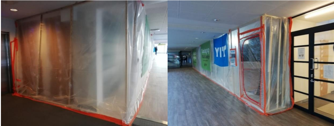
KUVA 4. Työmaan ja Yliopiston käytävän välinen suojaseinä (kuva Laura Häkkinä 2018)
