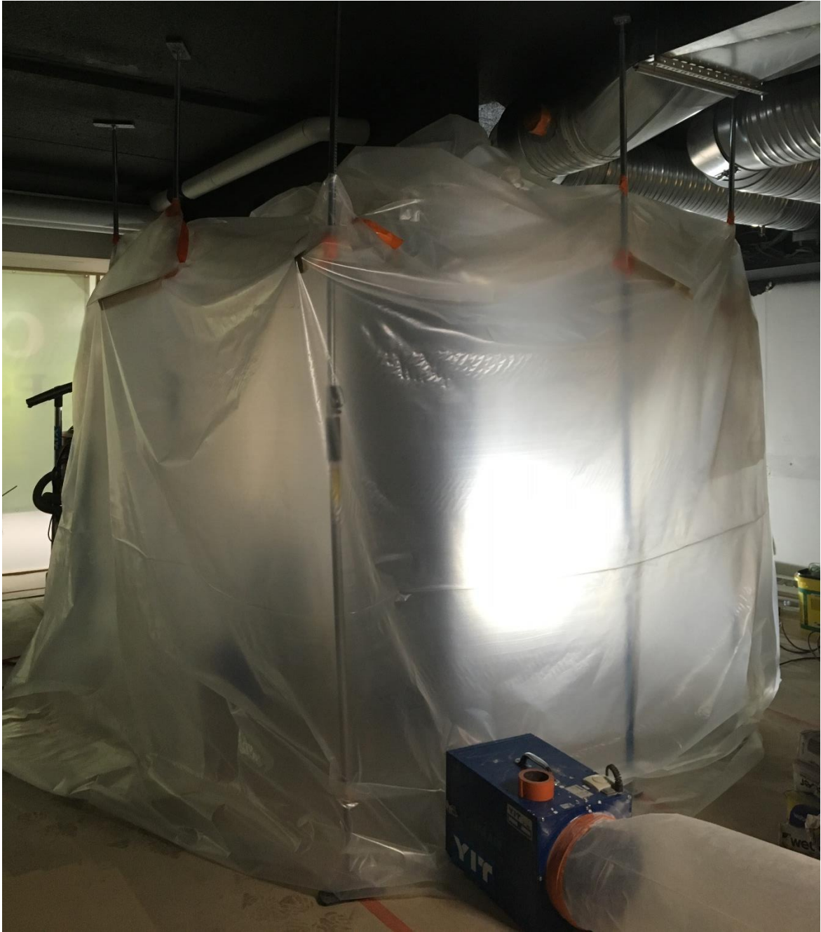
KUVA 3. Soodapuhalluksen osastointi muusta työmaasta (kuva Laura Häkklä 2018)
