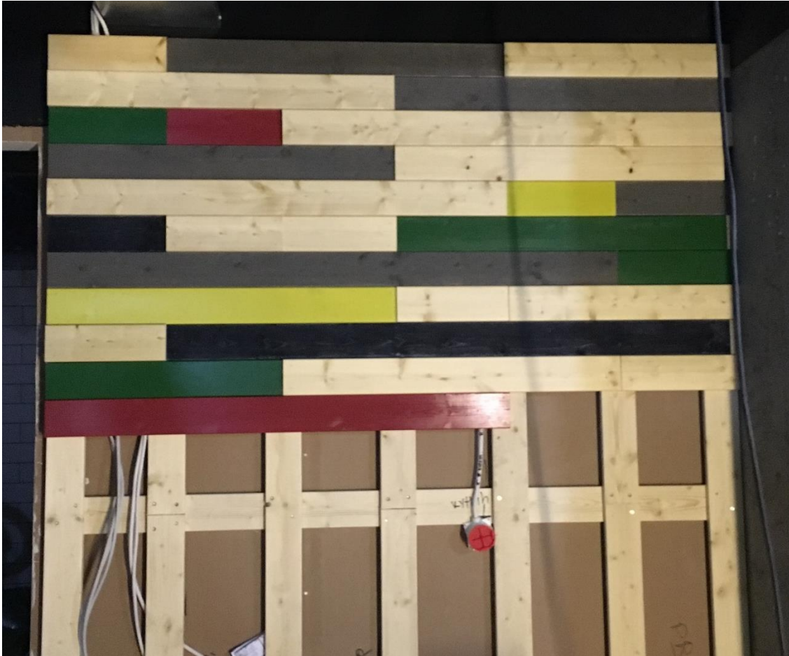
KUVA 8. Kapulaseinän kasaus kesken. Valittu kiinnitystapa ei näy valmiissa pinnassa juuri ollenkaan. (kuva Laura Häkkinä 2018)
