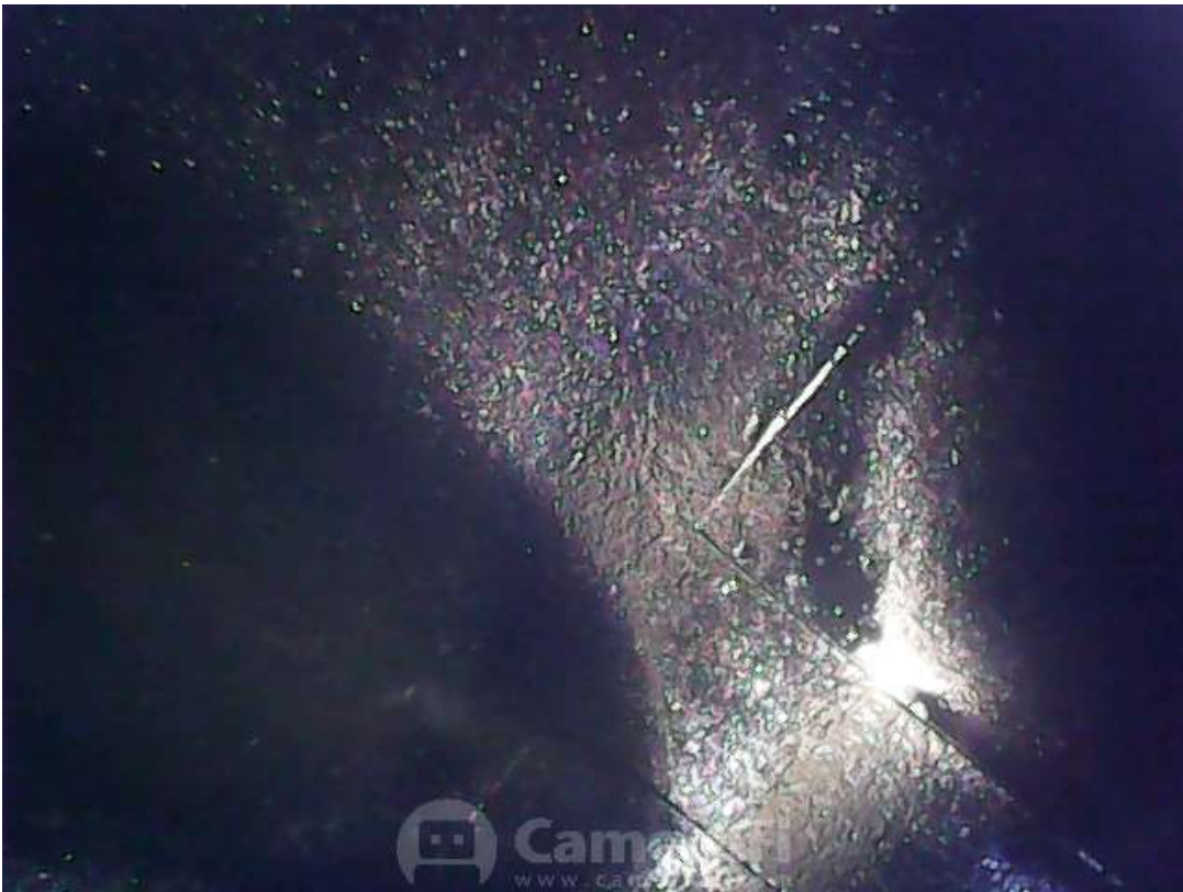
KUVA 25 Imusarja, ylemmässä kuvassa ennen ja alemmassa puhdistuksen jälkeen
