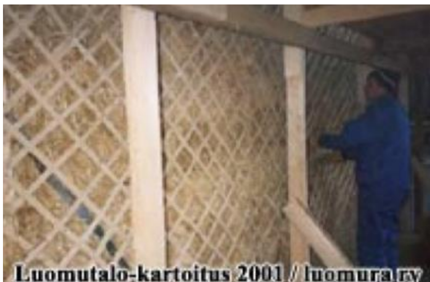
Kuva 18. Olkipaaliseinän rakennetta Jollaksen Ekoateljeessa.
