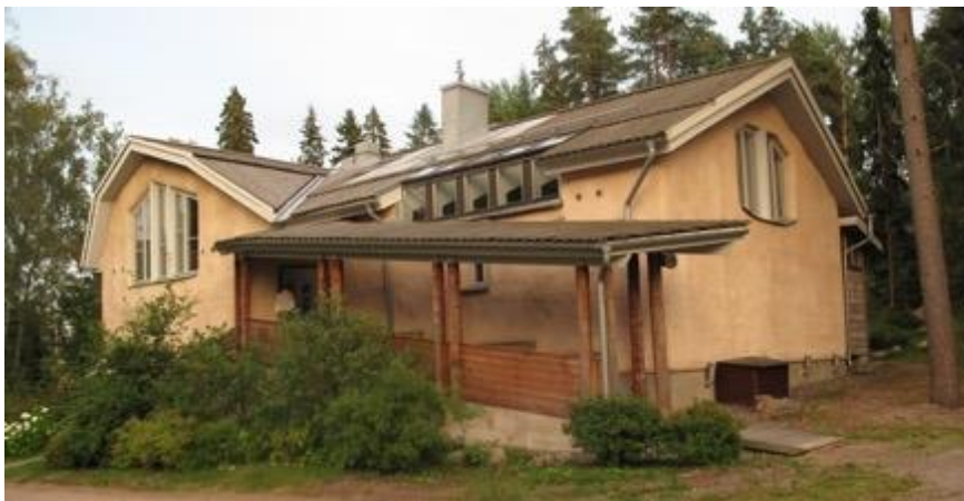
Kuva 19. Helsingin Jollaksessa sijaitseva Ekoateljee, joka rakentamiseen on käytetty olkea
