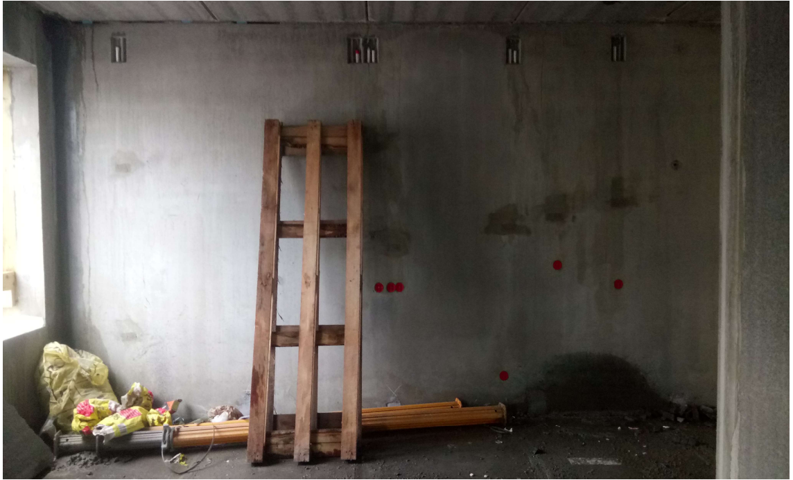
Kuva 8. WM-varaukset valmiissa elementissä työmaalla, huoneeseen asennetaan alakatto.
