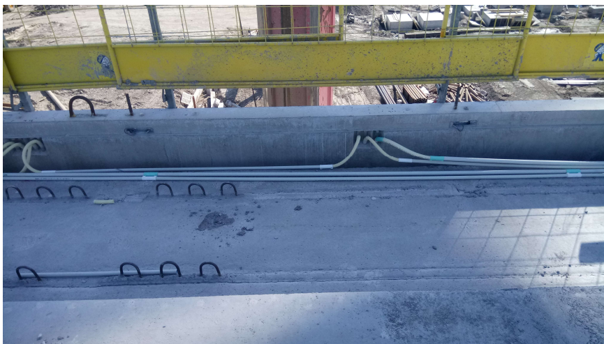
Kuva 9. W-varaukset sekä putkitukset työmaalla.
