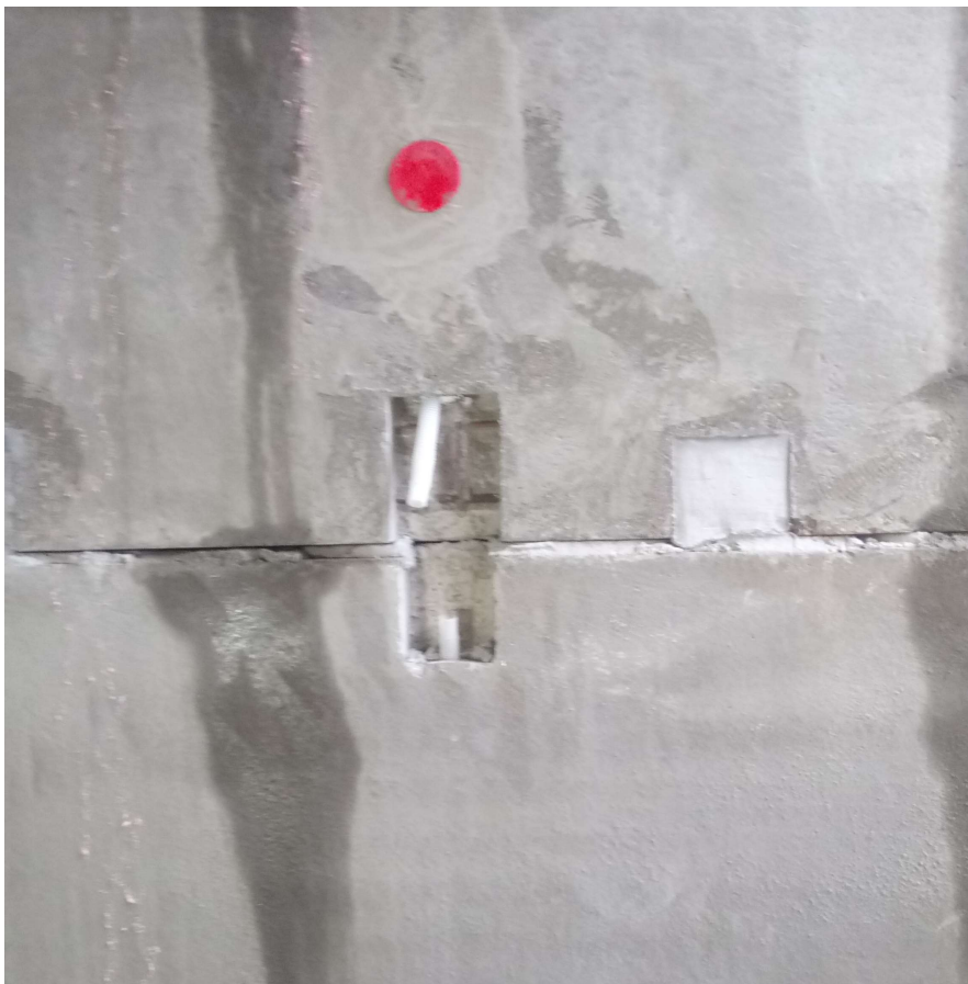
Kuva 26. Onnistunut porraskäytävävaraus, varaukset osuneet vastakkain, joten putkitusta on helppo jatkaa.
