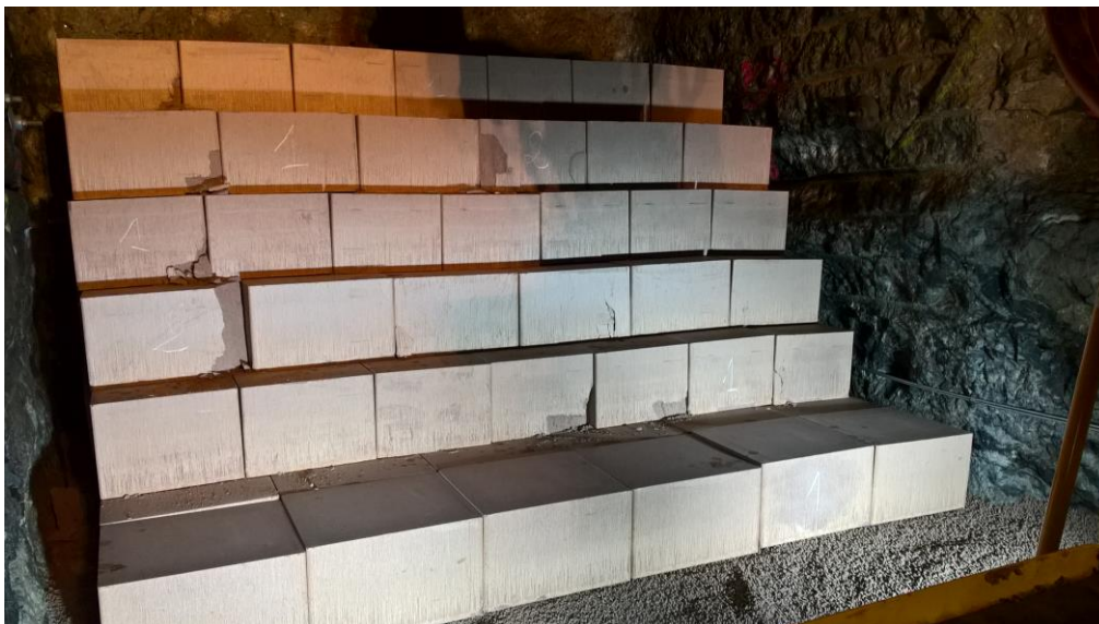
Kuva 7. Loppusijoitustunnelin täyttölohkot. Posiva Oy. (Kuva: Risto-Matti Meriniemi, 2018.)
