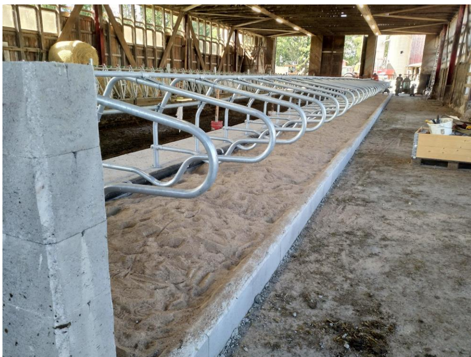
Kuva 25. Hiekkaparsien asennus
