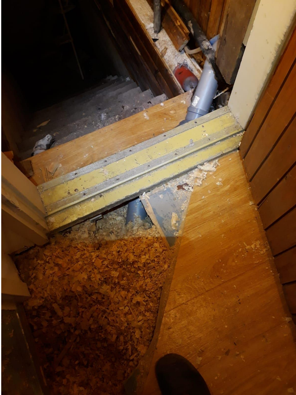
Kuva 8. Roskavalun päällä olevaa purueristystä. (Pirhonen 2017).
