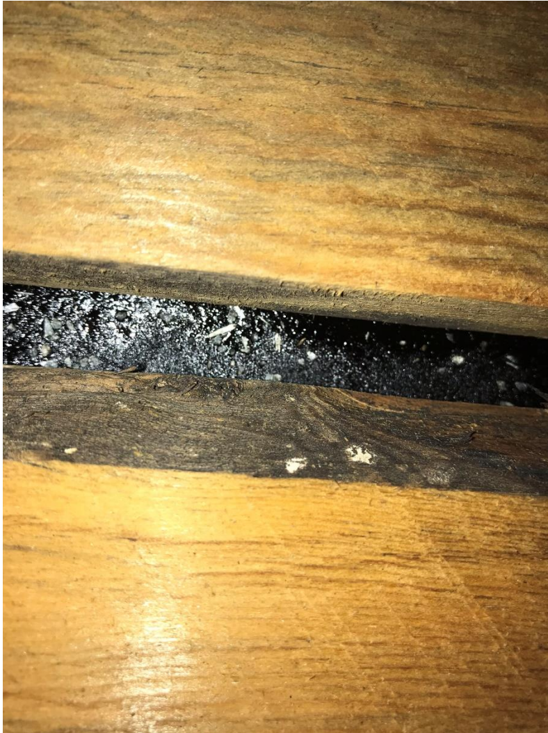
Kuva 6. Huopakate näkyy laudoituksen välistä.
