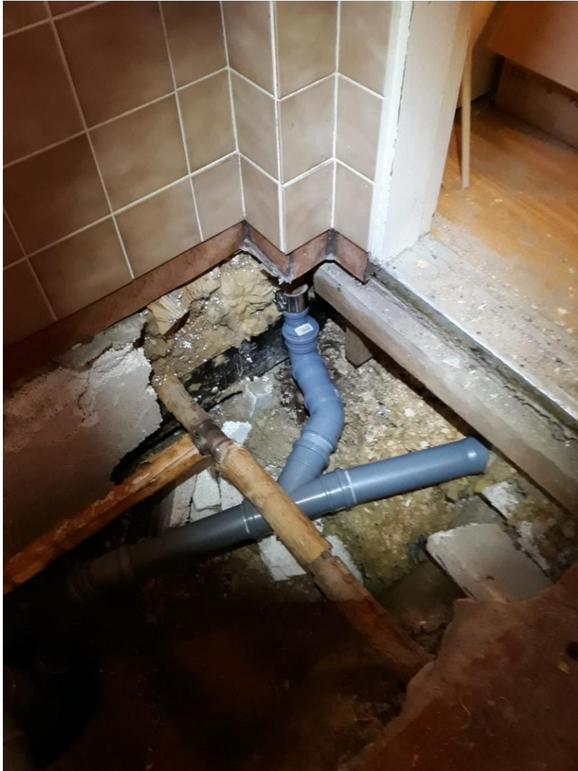
Kuva 3. Kylpyhuoneesta purettu lattiaa uutta viemäröintiä varten. (Pirhonen 2017).
