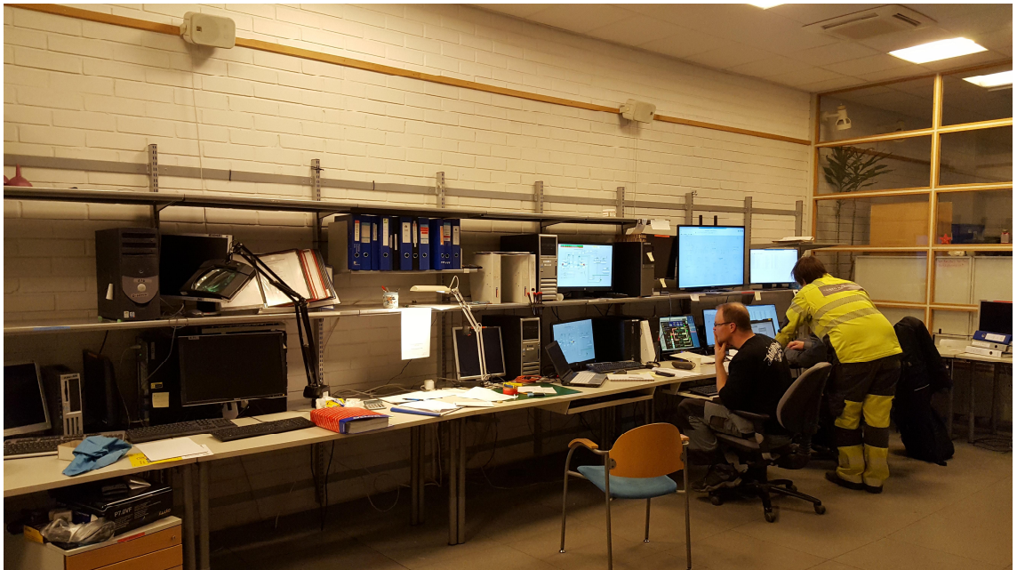
Kuva 18. Meilahden sairaala-alueen sähkövalvomo.
