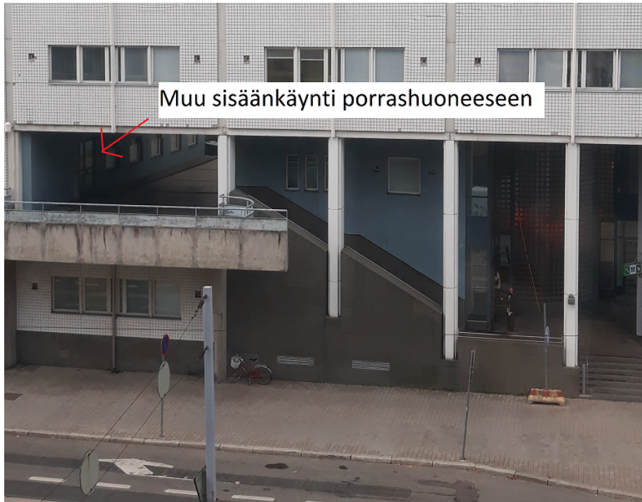
Kuva 2. Sisäänkäynti ei ole julkisivussa. Sisäänkäynti on lipan alla sisennyksessä, rakennuksen vaipan sisäpuolella. Asemapäällikönkatu 14, Helsinki.
