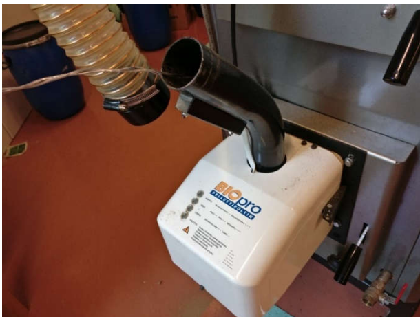
Kuva 26. Syöttöputken tukoksen aukaiseminen rautalangan avulla
