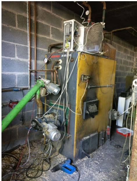
Kuva 39. Konepaja M. Pappinen Oy:n pellettipoltin
