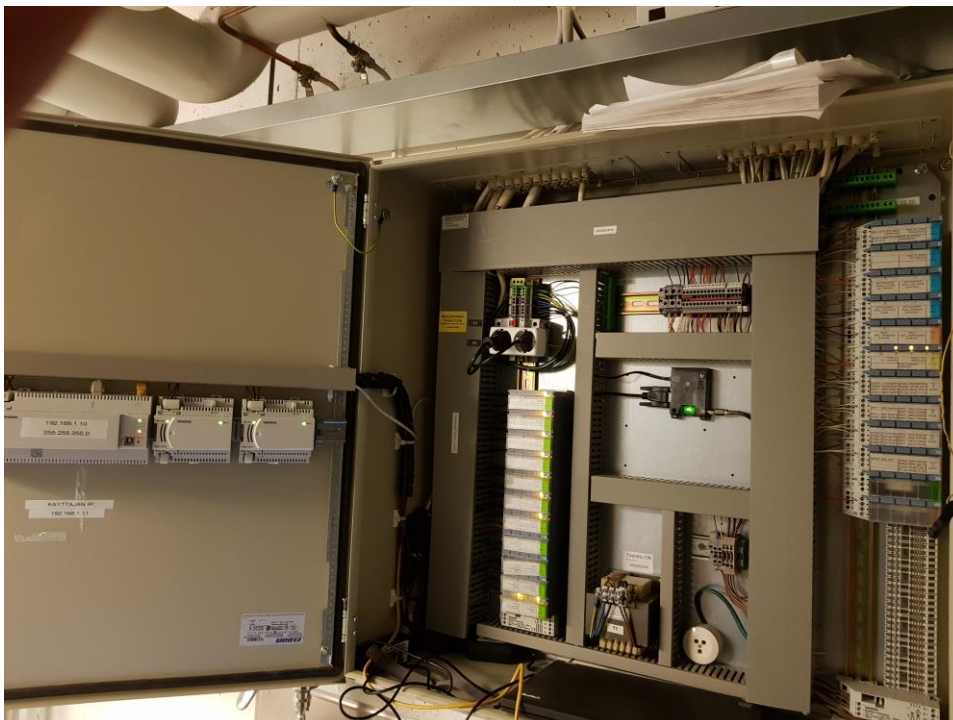
Kuva 18. Alakeskus asennustöiden jälkeen
