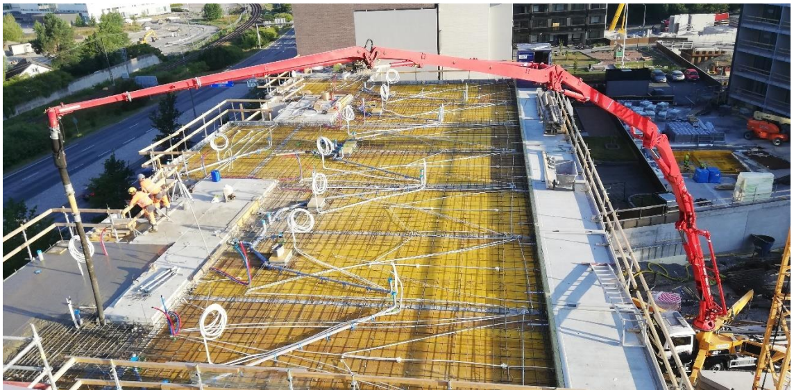
Kuva 7. Neljännen kerroksen betonointi.
