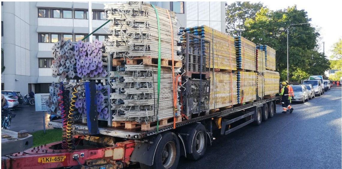
Kuva 8. Holvimuottikalusto oikeaan aikaan työmaalla.
