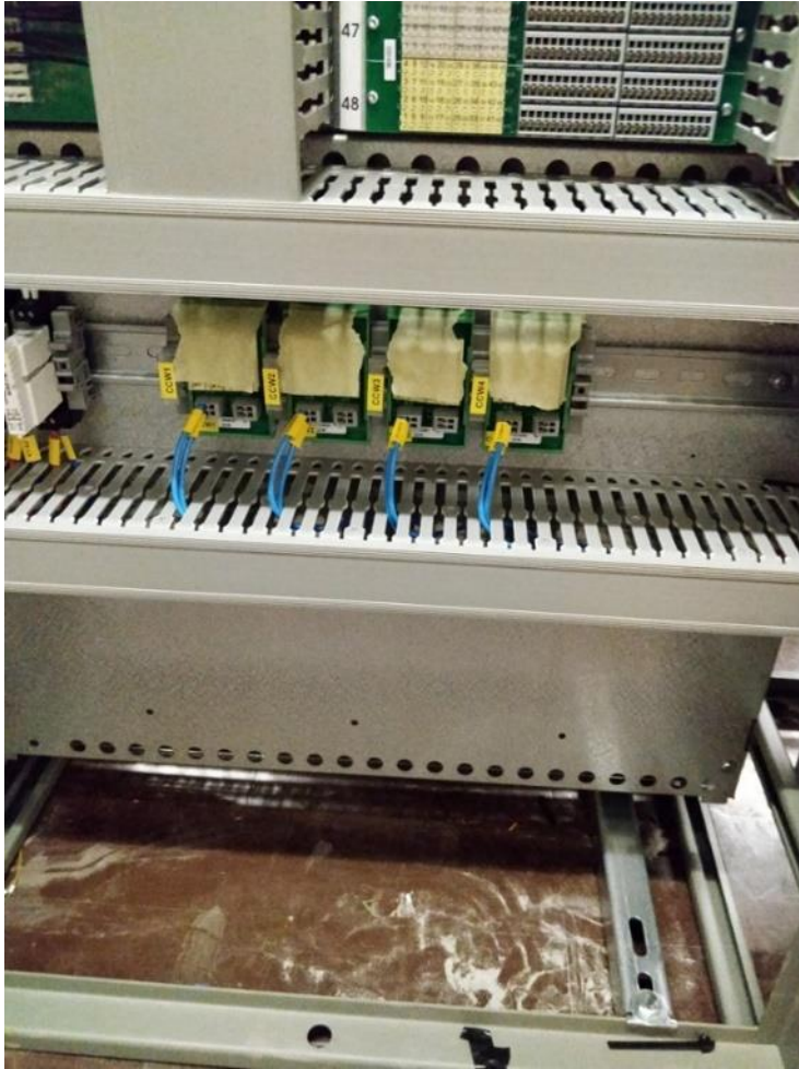
KUVA 38. CCW-liittimet, kaapin yhteinen maadoituspiste
