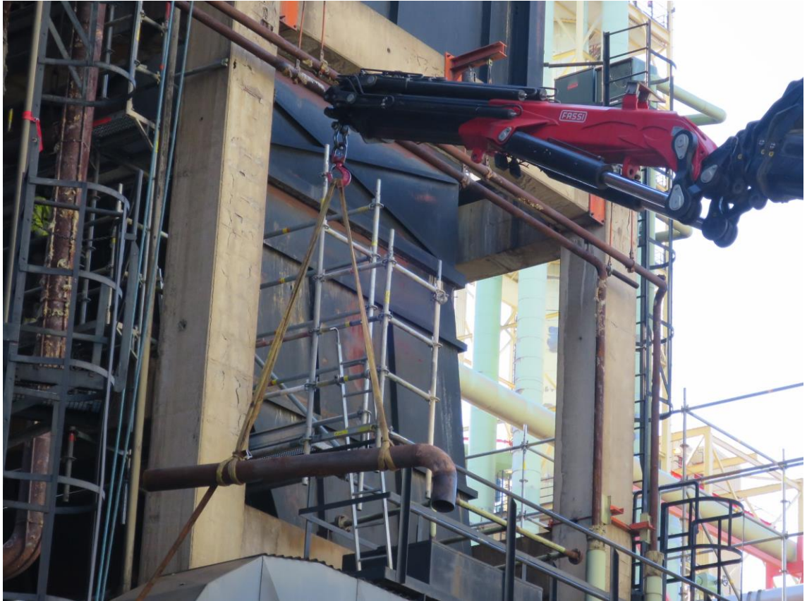
Kuva 2. Putkiston nostotyö HIAB-kuormausnosturilla
