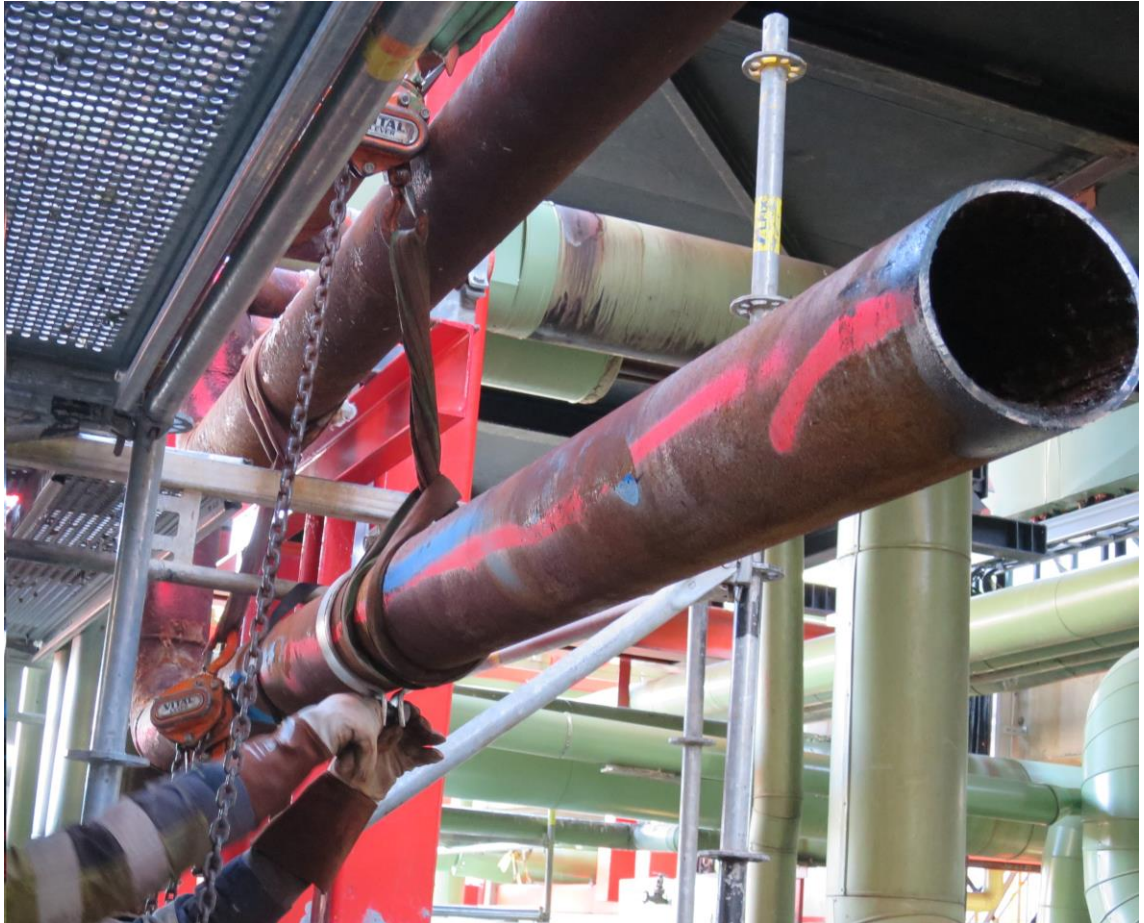
Kuva 1. Putkiston väliaikainen tuenta ja katkaisukohdan varmistus
