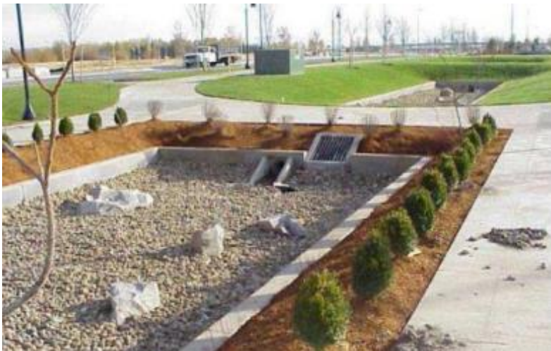
KUVA 12. Avonainen imeytyskaivanto (Uuramo 2018)
