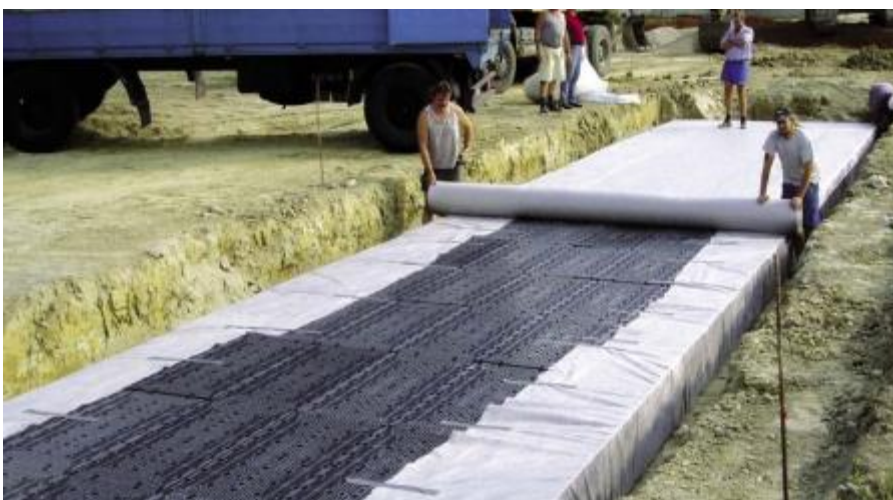
KUVA 13. Hulevesikasettien ympärille kiedotaan suodatinkangas ennen peittämistä (Uponor 2012)
