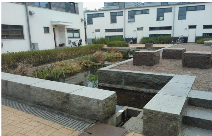
KUVA 2. Malmössä sijaitseva hulevesikanava asuinalueella (Elo 2018)
