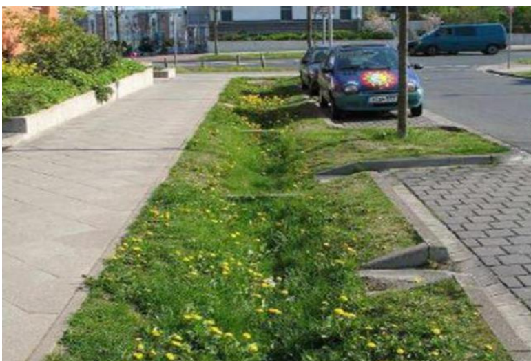
KUVA 5. Mulden-Rigolessa sijaitseva hulevesipainanne (Kajanus 2010)
