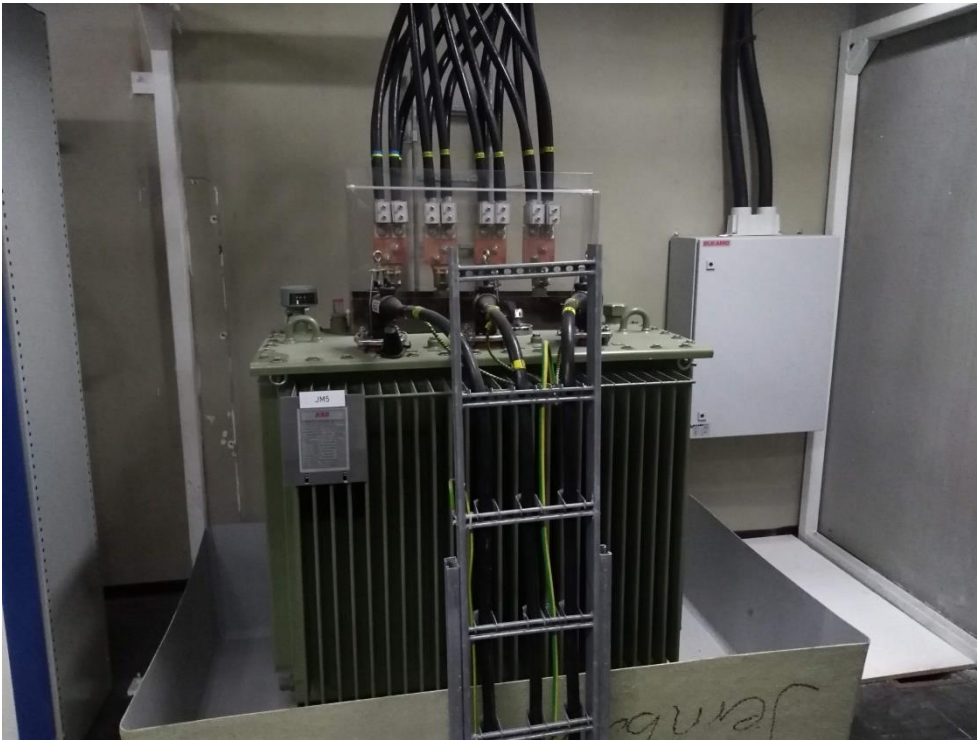
KUVA 6. ABB-konsernin valmistama 500 kVA:n hermeettinen muuntaja
