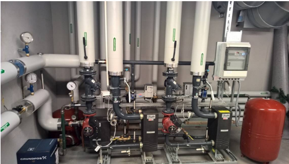
KUVA 3. Lämmönjakokeskus
