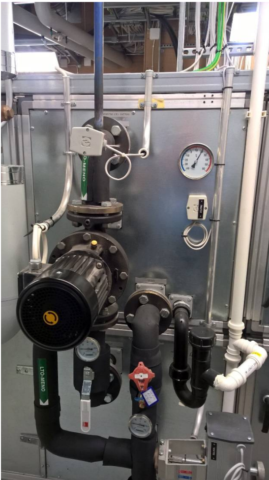
KUVA 8. Mittalähettämiä ja toimilaitemoottori
