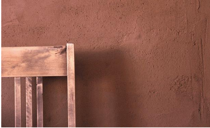
Kuva 20. Rouheaksi jätetty savirappauspinta (The Natural Building Company 2016)
