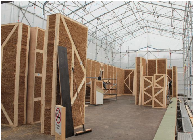
Kuva 11. Olkielementtejä asennettavana työmaalla (The Natural Building Company Oy 2019a)
