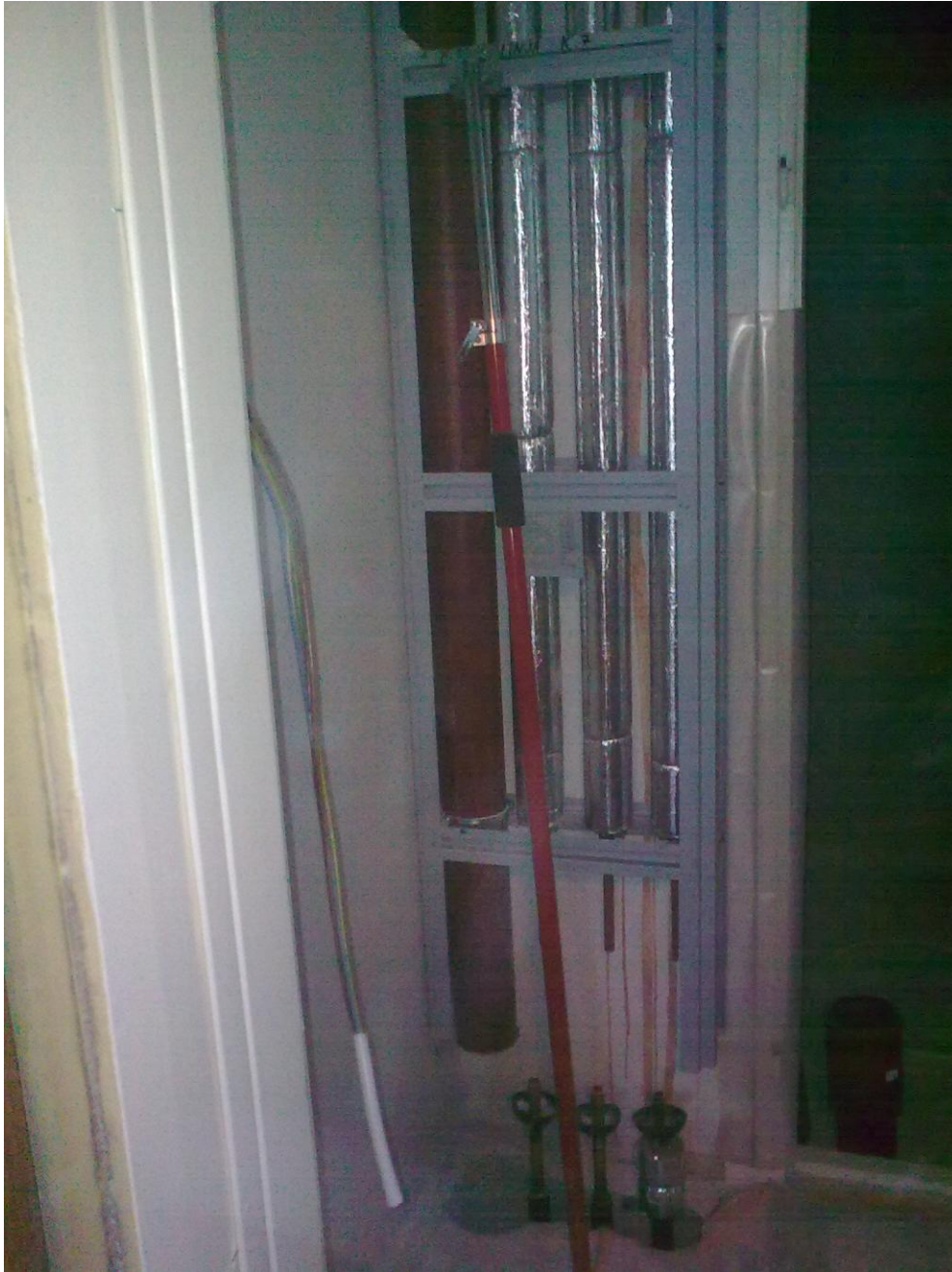
Kuva 3. Talotekniikkaelementti asennusvaiheessa.
