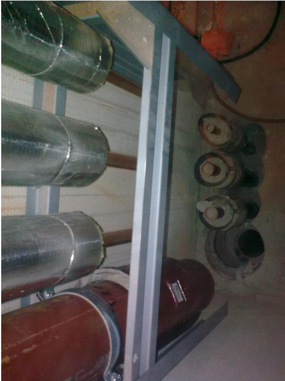
Kuva 1. Talotekniikkaelementtejä liitosvaiheessa.
