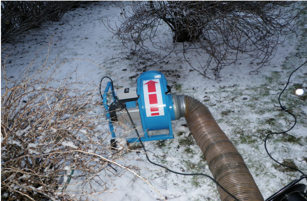
Kuva 6. Nuohoustapahtuman aluksi raitisilmasäleikkö on poistettu ja alipainepuhallin liitetty kanavistoon
