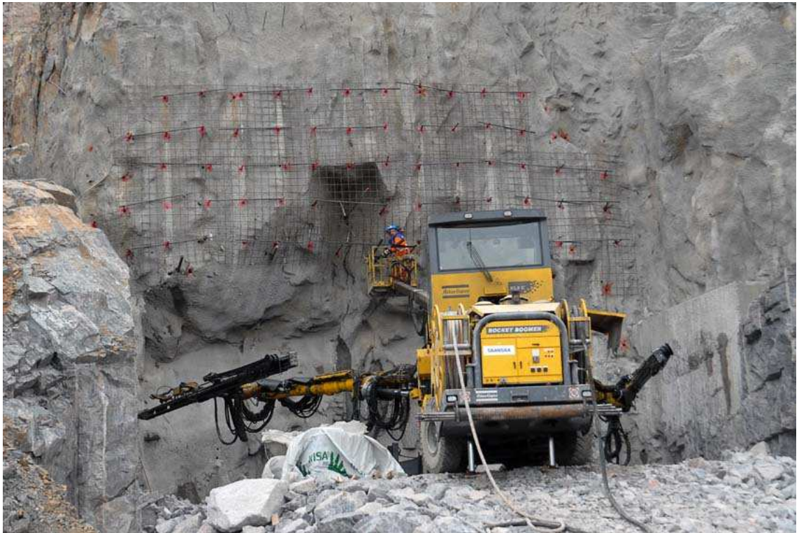
Kuva 4. Porausjumbo tunnelin suuaukolla (8).
