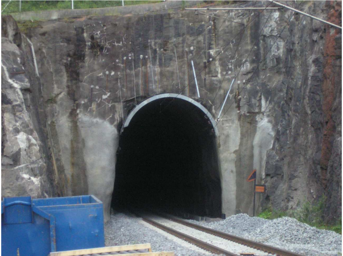
Kuva. Paavalinvuoren ratatunnelin suuaukko, jossa JT-mittaus Oy on suorittanut mittaustehtäviä (5).
