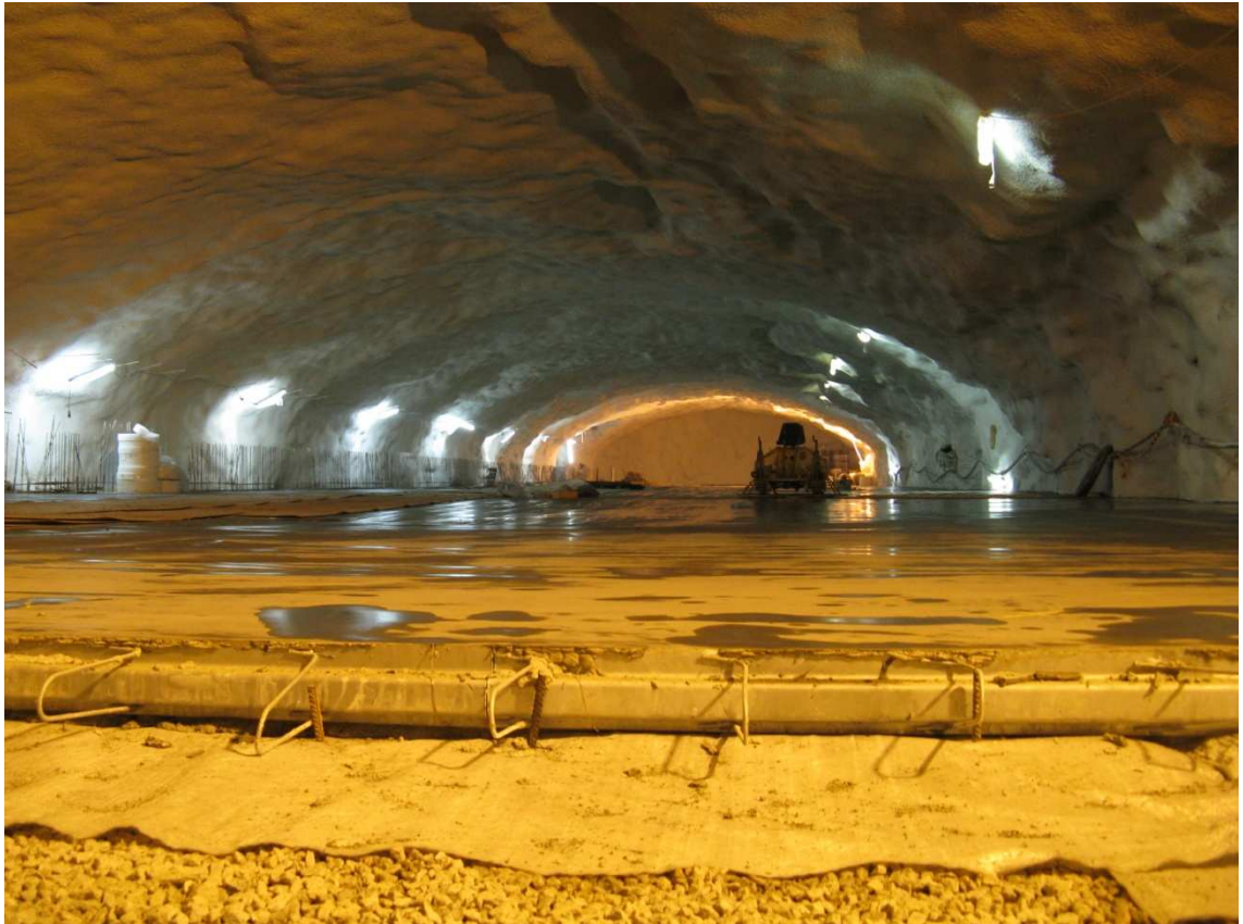
Kuva 10. Kuvassa Viikin uuden väestönsuojan pysäköintihallin osa on valettu seuraavaan liikuntasaumaan saakka (8).
