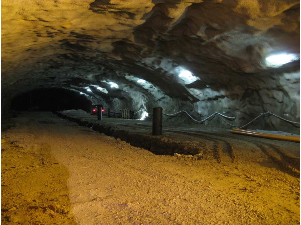
Kuva 6. Kaivoverkoston asentaminen Viikin uuden väestönsuojan parkkihallissa (11).
