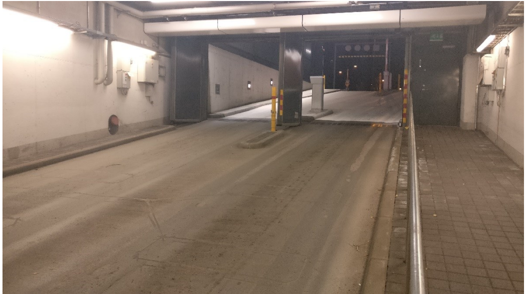
Kuva 6. Parkkihallin induktiosilmukoilla toimivat ovet
