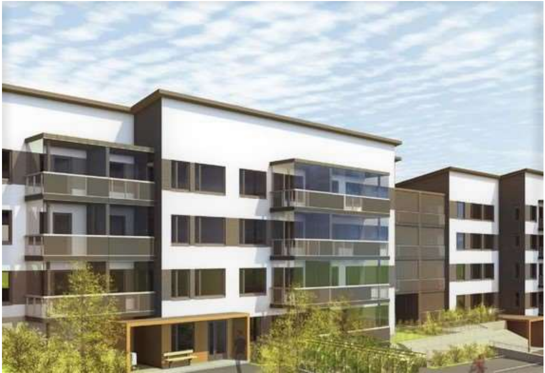
Kuvio 4. Asunto Oy Jyväskylän Kultatikassa kelluvat pintalattiat valettiin betonista. (Peab ennakkomarkkinointiesite 2014)
