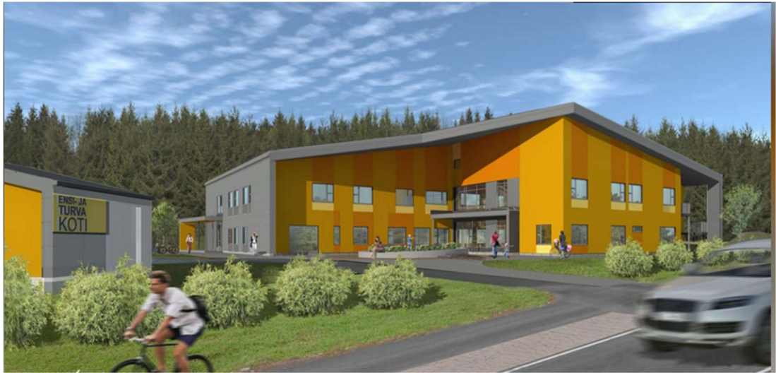
Kuvio 13. Keski-Suomen ensi- ja turvakodin kelluvat pintalattiat valettiin sementtipohjaisella kuituvahvistetulla tasoitteella. (Keski-Suomen ensi- ja turvakodin uuden kiinteistön rakentaminen käynnistyy 2018.)
