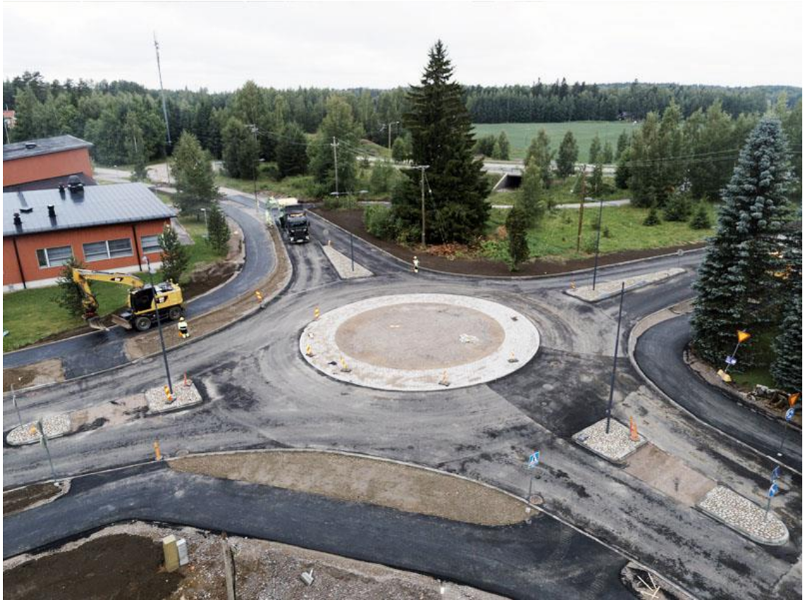
Kuva 5. Paijalan koulun läheisyyteen rakennettava uusi kiertoliittymä. [6.]
