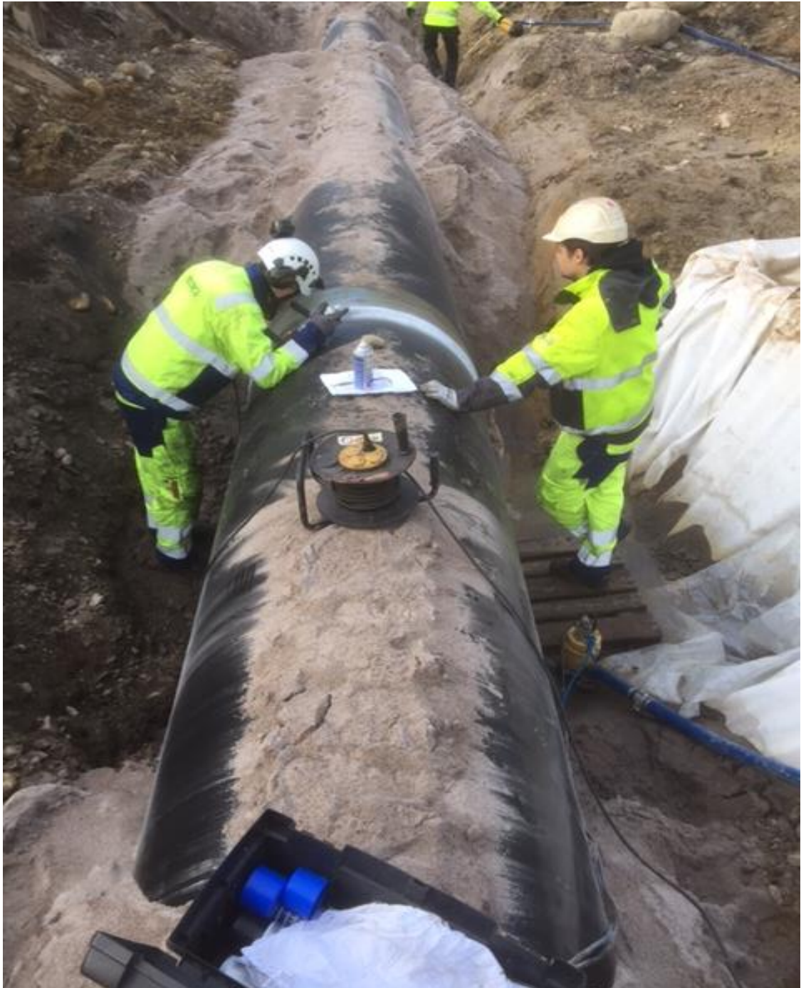
Kuva 7. 1000 mm runkovesijohdon hitsausliitoksen laadunvarmistuskokeiden suoritus käynnissä. [6.]
