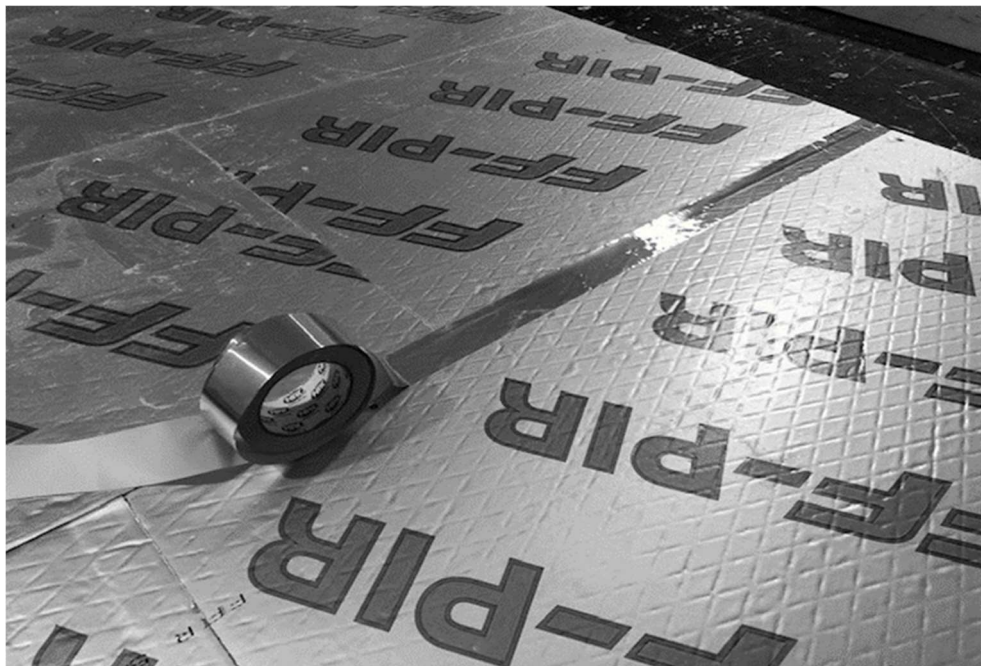
Kuva 30. Uretaanivaaho uretaanilevyn ponttiin.
