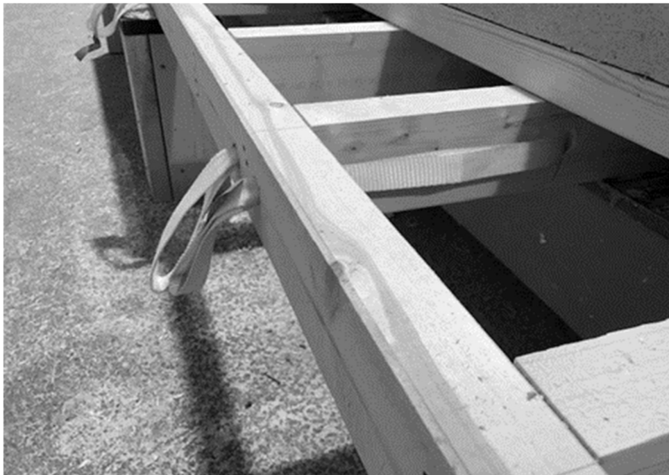
Kuva 22. Umpinostovyöt asennettuna runkotolppiin.
