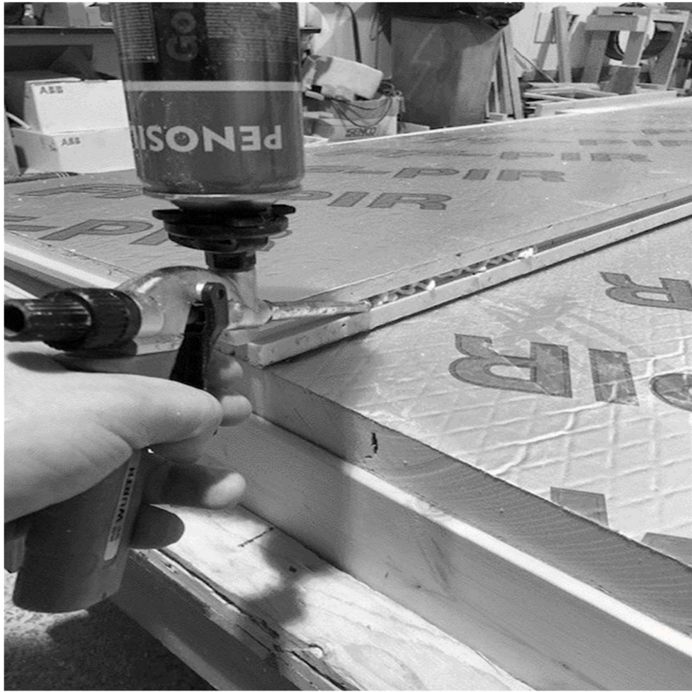
Kuva 30. Uretaanivaaho uretaanilevyn ponttiin.
