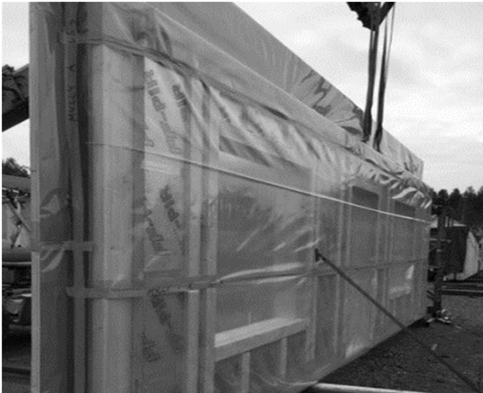
Kuva 19. Varastoitu, suojattu suurelementti.
