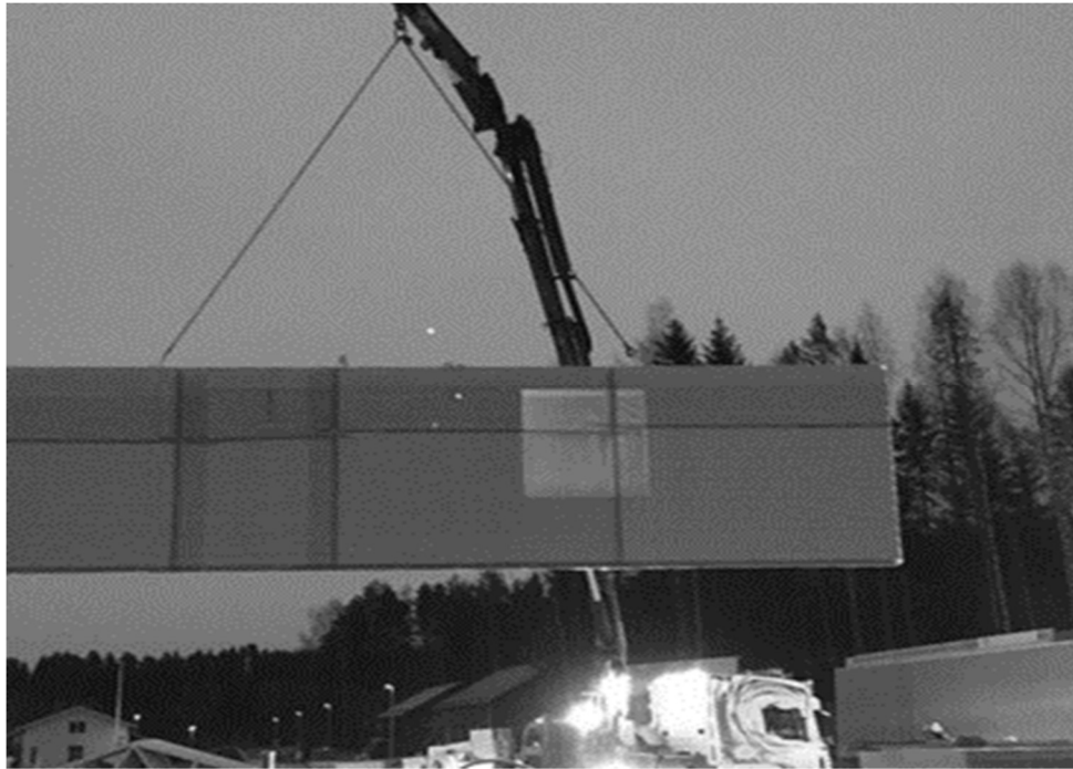
Kuva 23. Puurunkoisen suurelementin nosto autonosturilla työmaalla.
