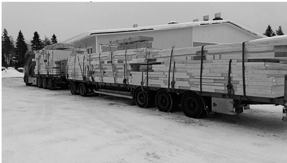
Kuva 21. CLT-elementit lastattu vaakakuormaksi ja kuorma lähdössä työmaalle (Paloniitty Oy, 2018).
