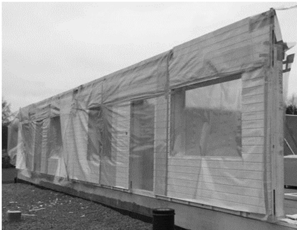
Kuva 20. Asennettu, suojattu elementti
